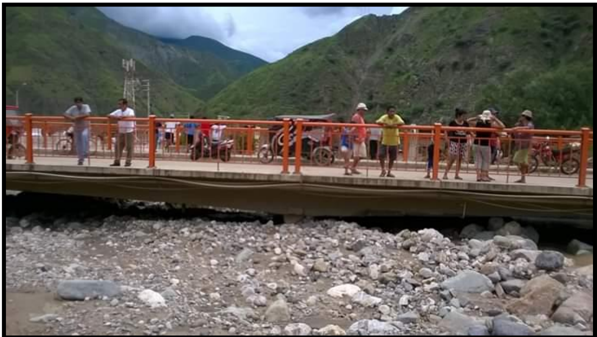
Ilustración 4: Puente Chilete saturado de material arrastrado por la quebrada de huertas.
