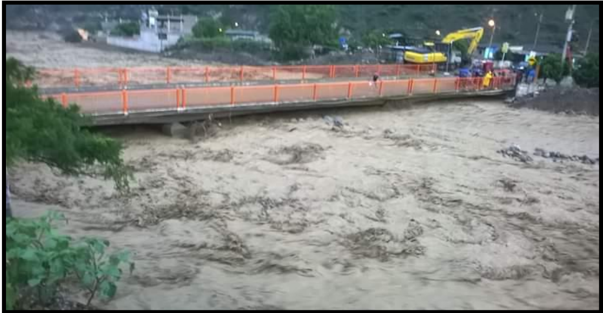
Ilustración 4: Puente Chilete saturado de material arrastrado por la quebrada de huertas.
