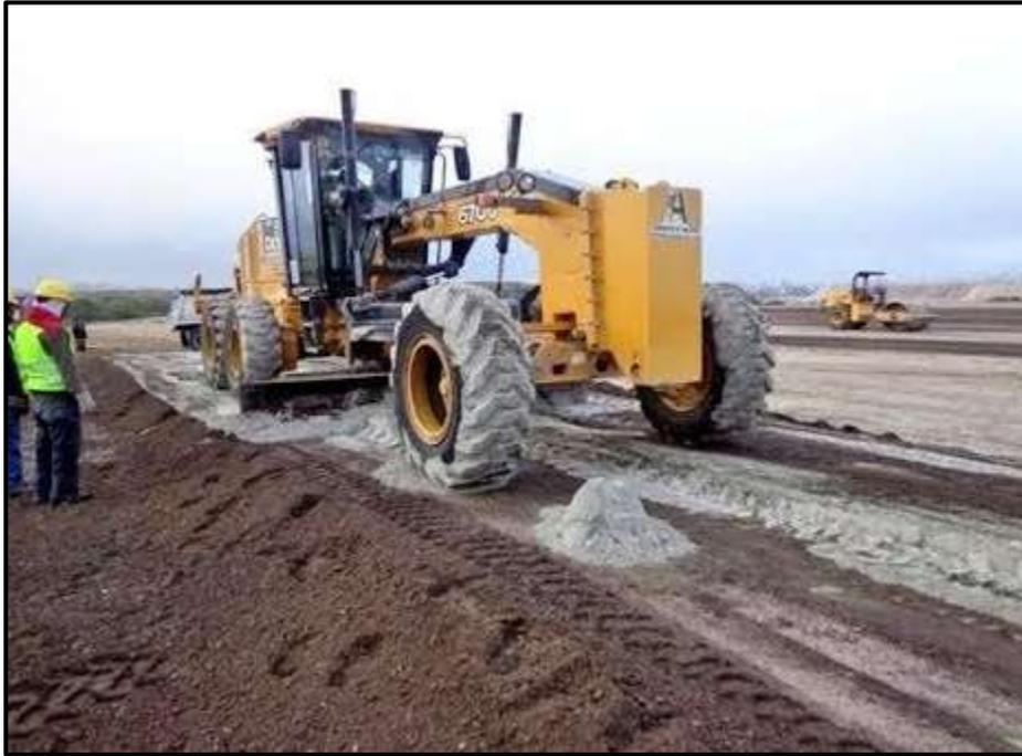
*Figura 4* Estabilización de suelo con cemento
