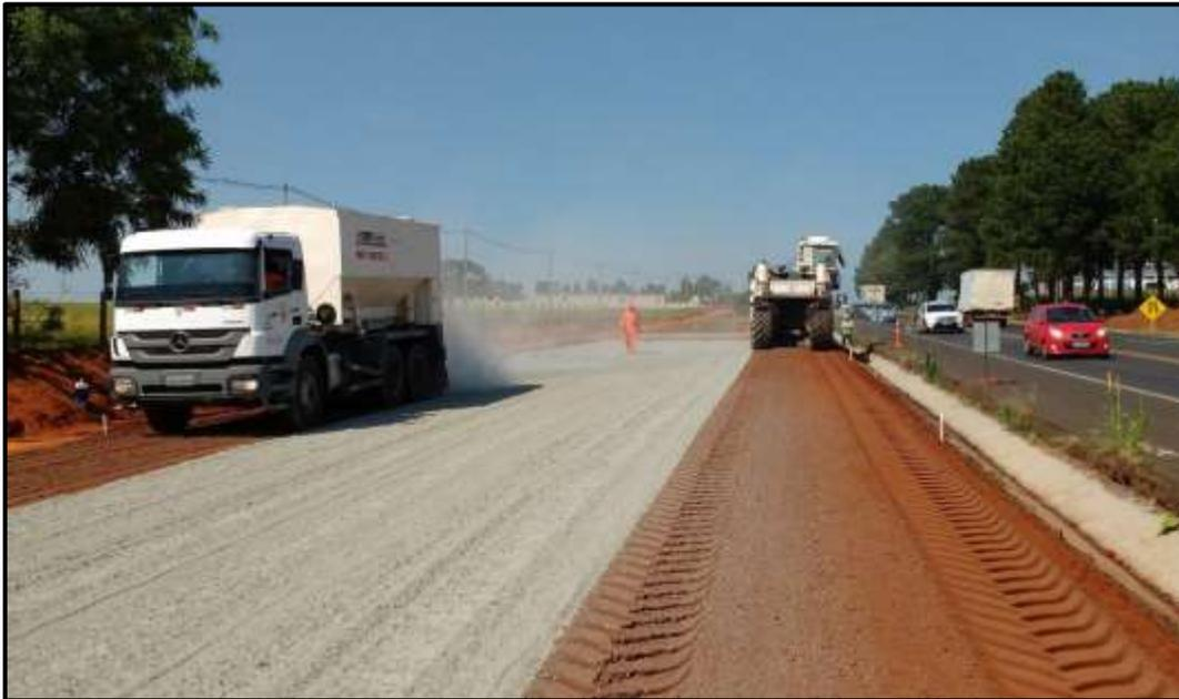
*Figura 5.* Estabilización con cemento
