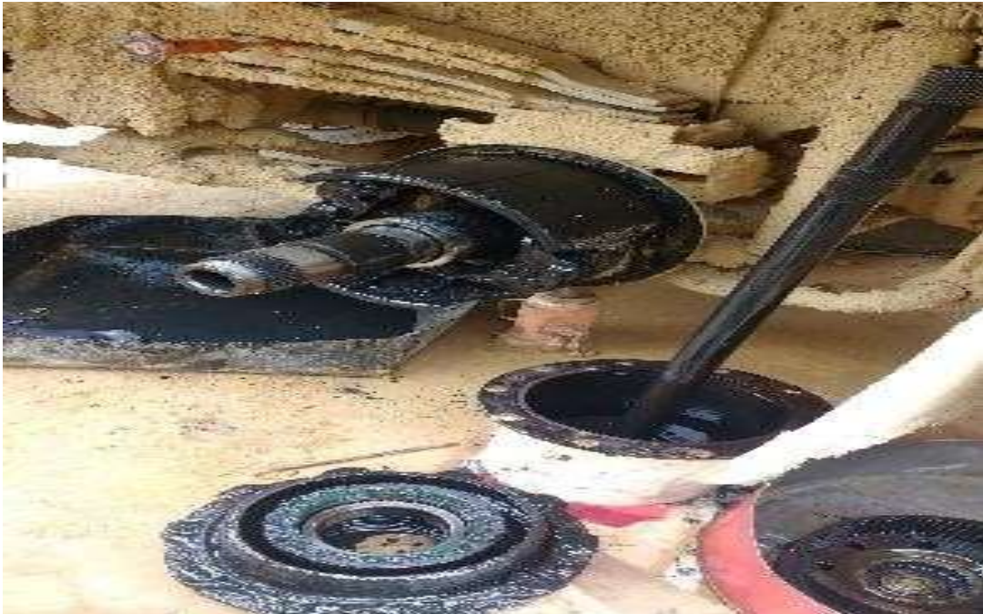
Ilustración 5: Mala ejecución de mantenimientos preventivos.
