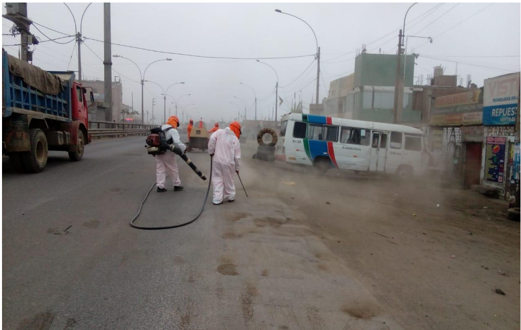
Figura n.º 6 Limpieza de Calzada (Durante) – Distrito Carabaylo
