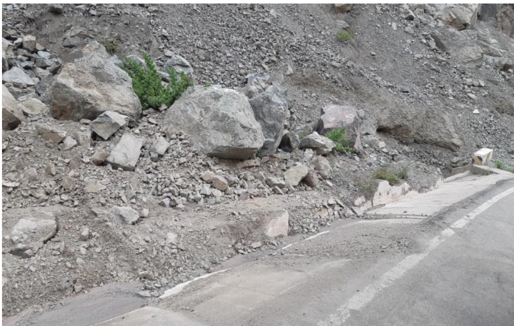
Figura n.º 10 Reposición de Cunetas (Antes) – CC.PP. Apán
