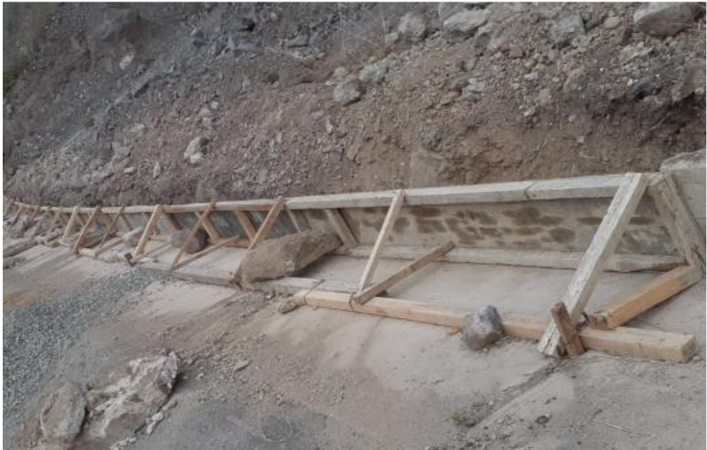
Figura n.º 12 Reposición de Cunetas (Después) – CC.PP. Apán
