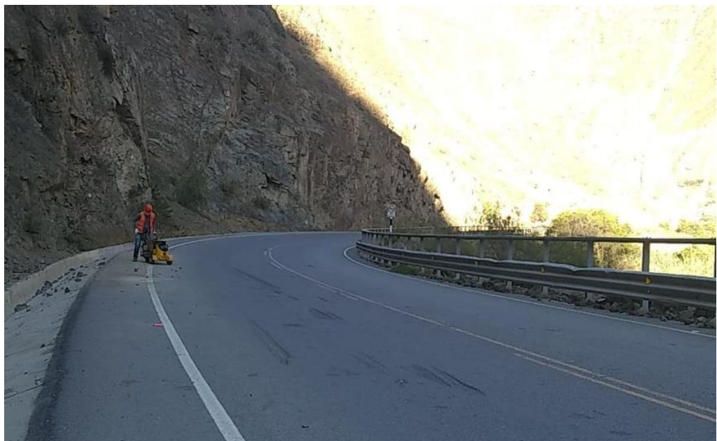
Figura n.º 15 Reposición de Tachas Retroreflectivas (Durante) – CC.PP. Yaso
