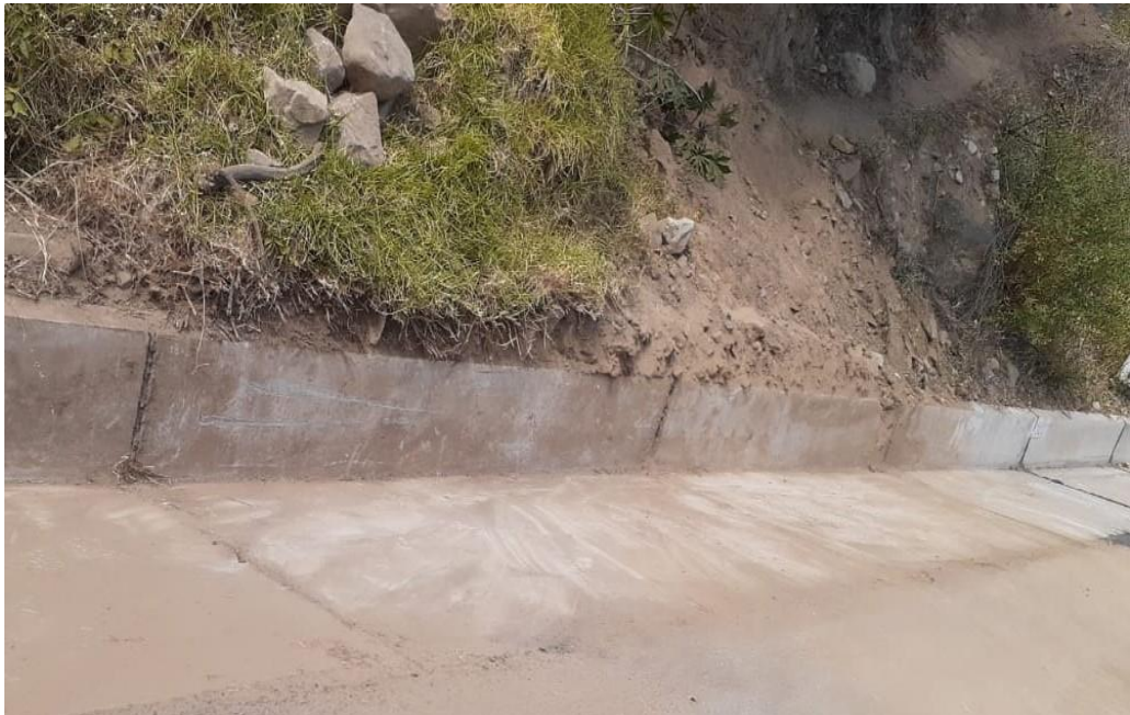
Figura n.º 9 Limpieza de Cunetas (Después) – CC.PP. Apán
