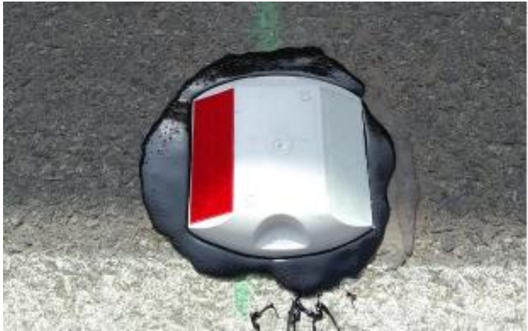
Figura n.º 16 Reposición de Tachas Retroreflectivas (Después) – CC.PP. Yaso
