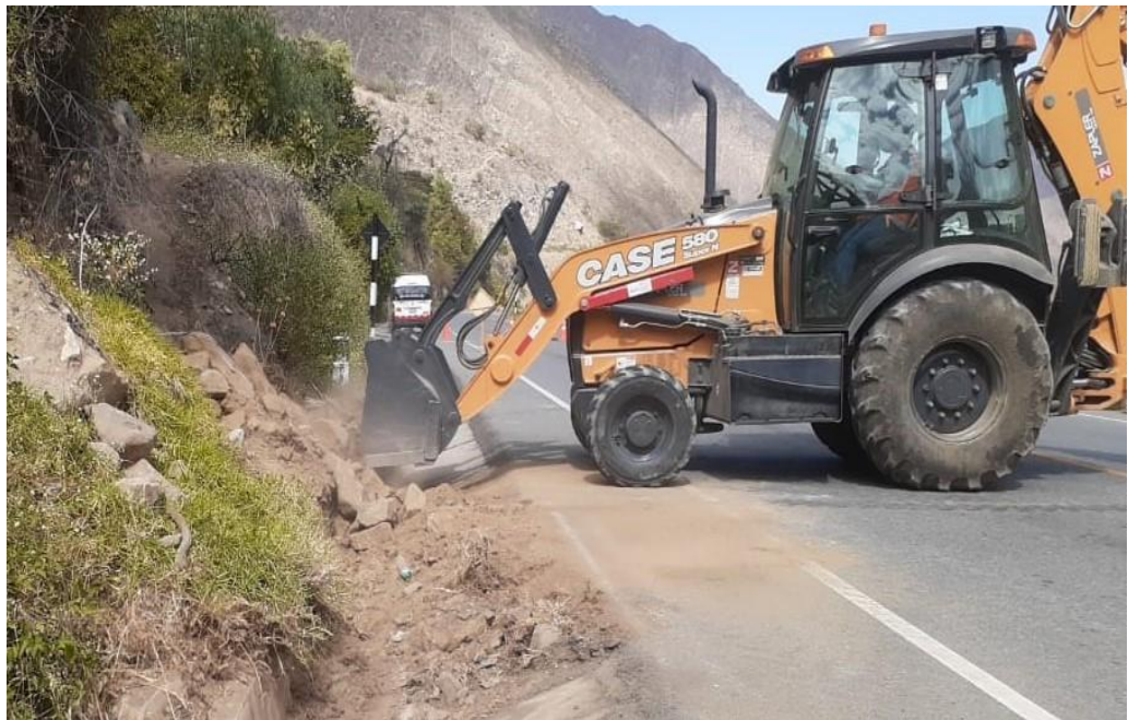
Figura n.º 8 Limpieza de Cunetas (Durante) – CC.PP. Apán
