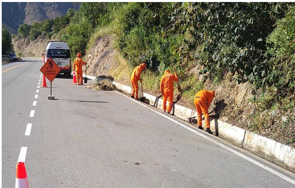
Figura n.º 8 Limpieza de Cunetas (Durante) – CC.PP. Apán
