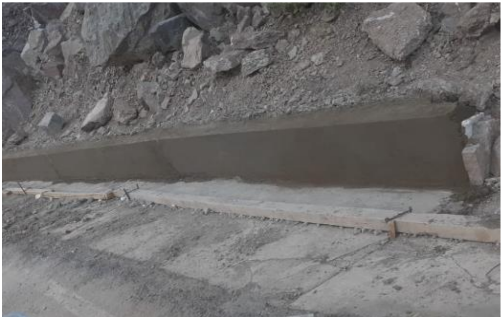
Figura n.º 12 Reposición de Cunetas (Después) – CC.PP. Apán
