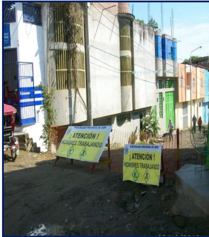
Foto 3 Vista mostrando el equipo de protección colectiva en obra
