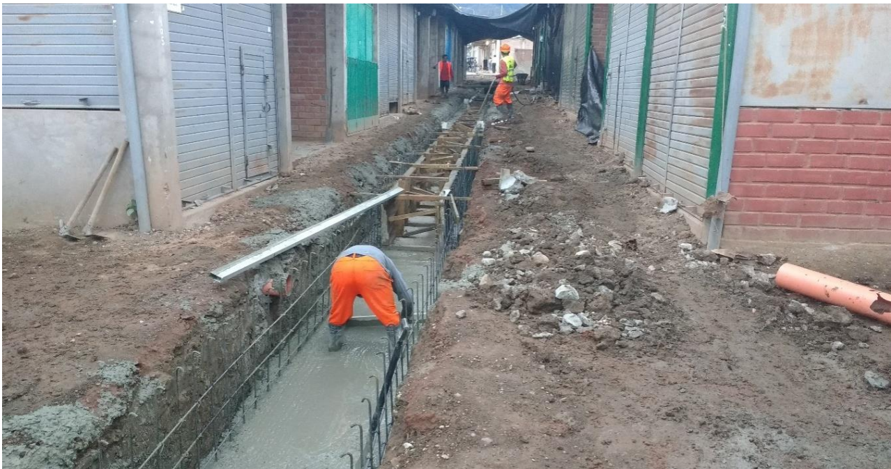
Foto 15 Vista mostrando la instalación de malla de acero a lo largo del canal proyectado por el interior del mercado Amoju
