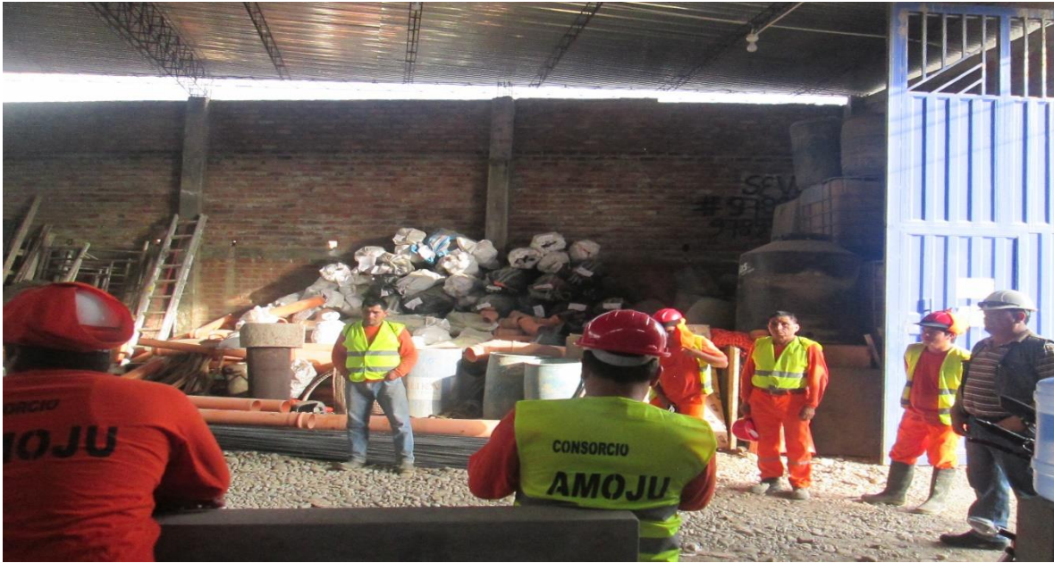
Foto 13 Se aprecia al bachiller en Ing. Civil Asistente de Residente, brindando charla de seguridad a los trabajadores del Consorcio Amoju antes del inicio de los trabajos diarios
