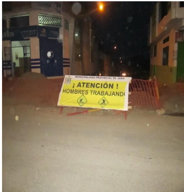
Foto 4 Vista mostrando el equipo de protección colectiva en obra
