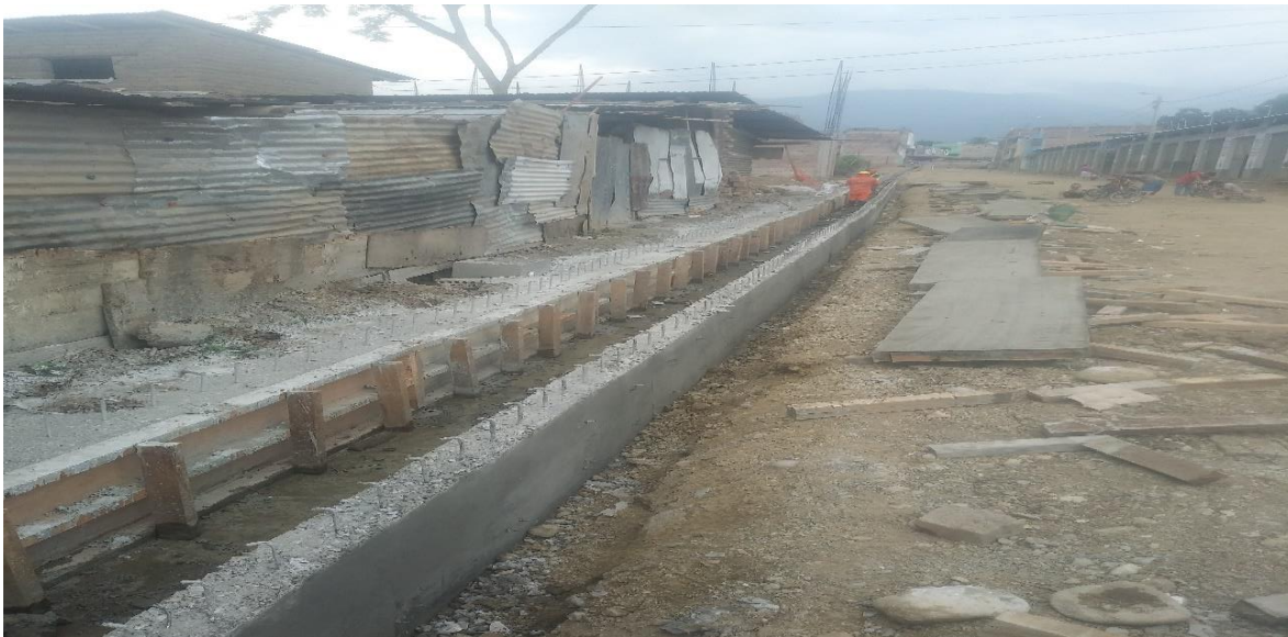
Foto 12 En la imagen se muestra la construcción de canal con concreto f'c=175 \text{ Kg/cm}^3 , para drenaje fluvial en la prolongación de la calle Antisuyo
