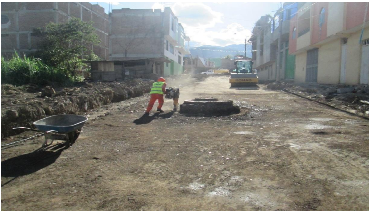
Foto 8 Compactación de la Sub Rasante calle Antisuyo
