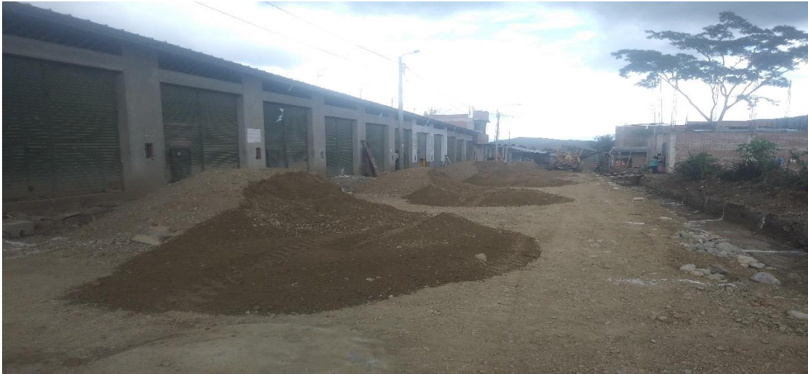
Foto 5 Abastecimiento de material afirmado a lo largo de la calle Prolongación Antisuyo
