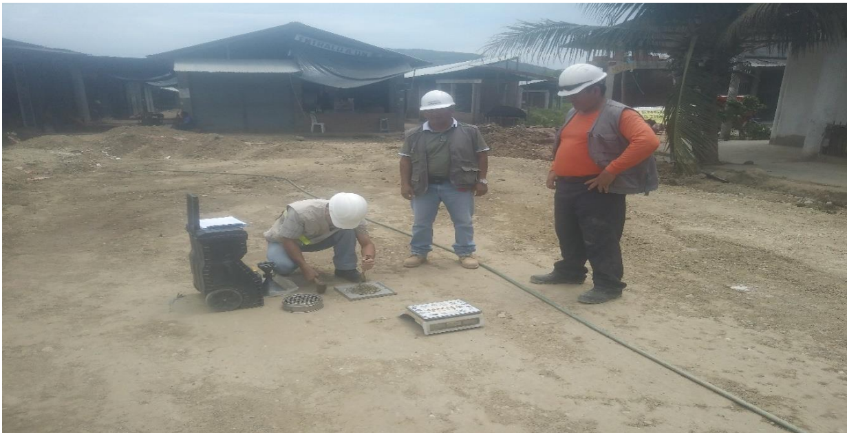
Foto 10 Personal profesional técnico de obra presenciando en campo el retiro de muestras para realizar las pruebas de compactación
