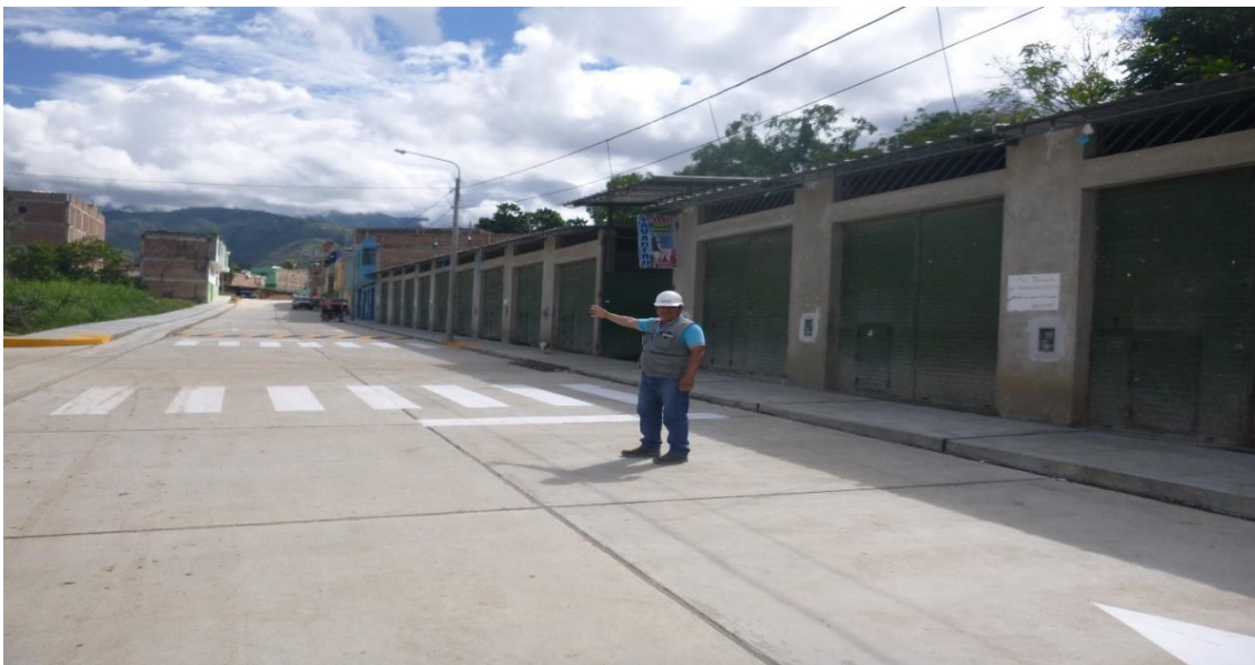
Foto 18 Ingeniero Asistente de Residente, mostrando la culminación total de la Obra (contrato principal y adicional de obra N° 01 – Lista para la recepción de Obra.
