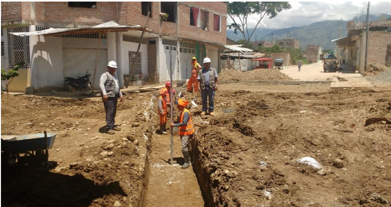
Foto 14 Vista mostrando al Ingeniero Supervisor y personal del Consorcio Amoju, verificando el reinicio de los trabajos concerniente al adicional de Obra N° 01
