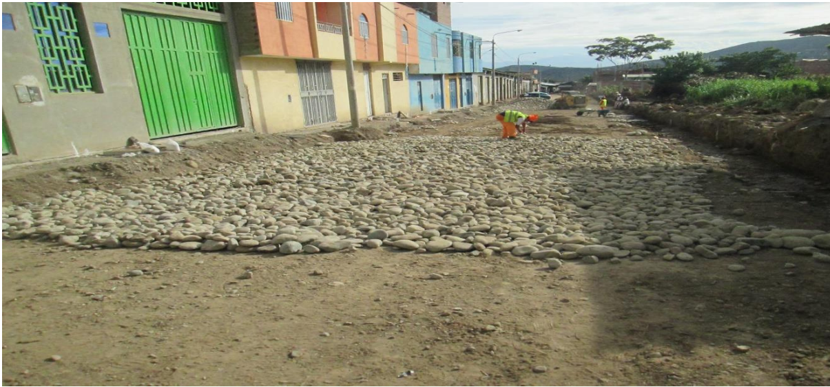
Foto 7 Distribución de la Piedra Over a lo largo de la subrasante de la calle Antisuyo
