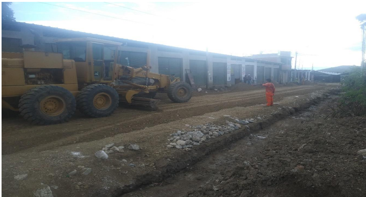
Foto 6 Se continúa la distribución de material afirmado con motoniveladora a lo largo de la calle Prolongación Antisuyo.
