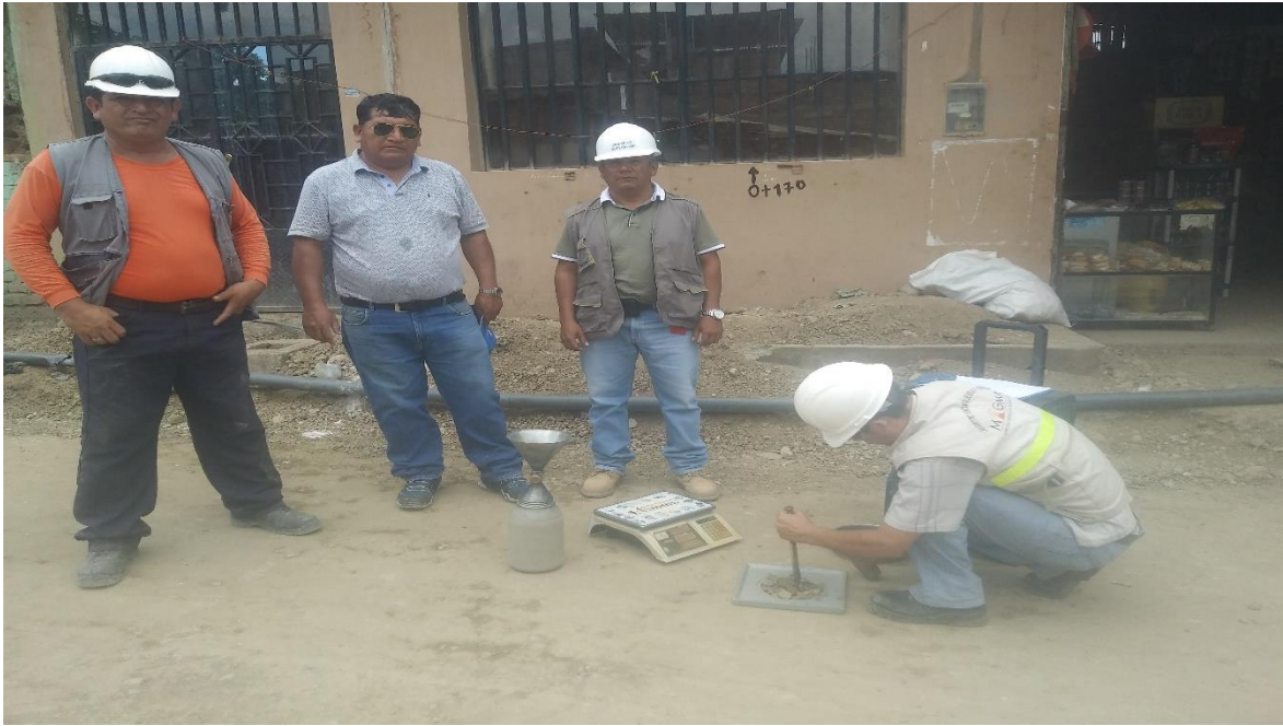
Foto 11 En la imagen se visualiza al personal profesional técnico de obra presenciando la realización de las pruebas de compactación del terreno donde se ejecuta la obra.
