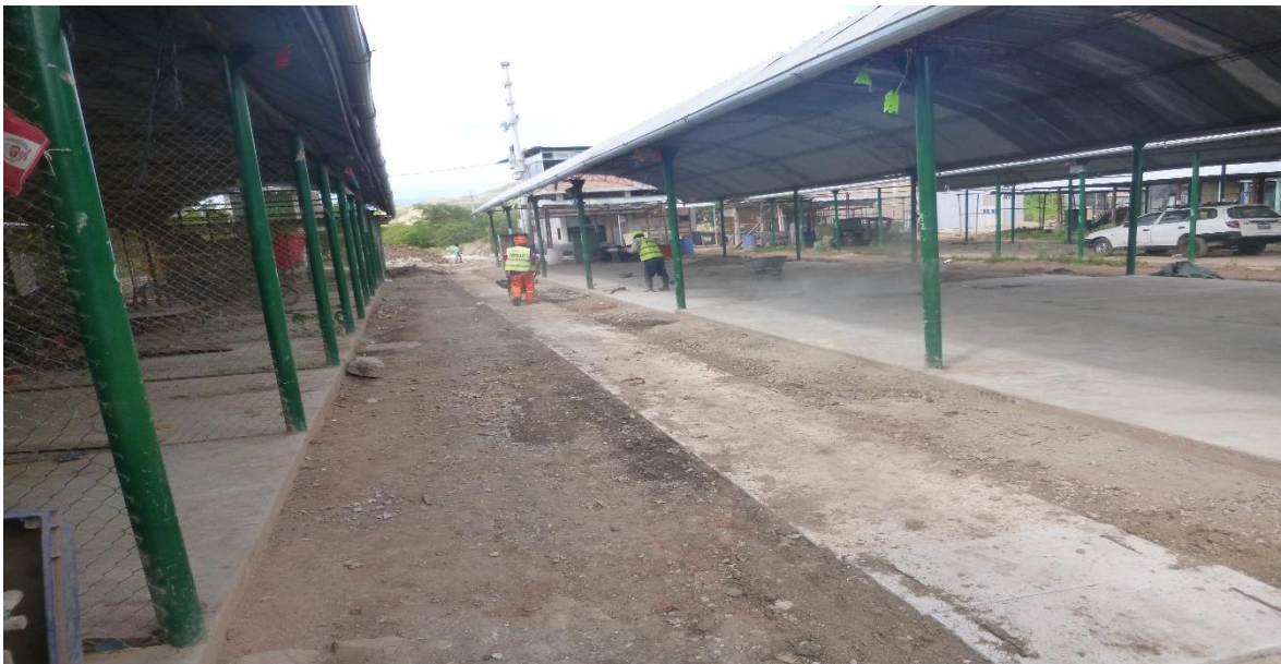
Foto 16 Vista mostrando el canal al interior del mercado Amoju, contemplado en el Adicional de Obra N° 01; al fondo personal realizando limpieza, de obra
