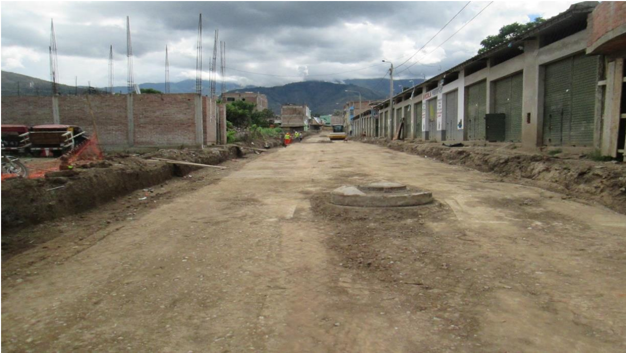
Foto 9 Vista de la sub rasante terminada en la calle Antisuyo
