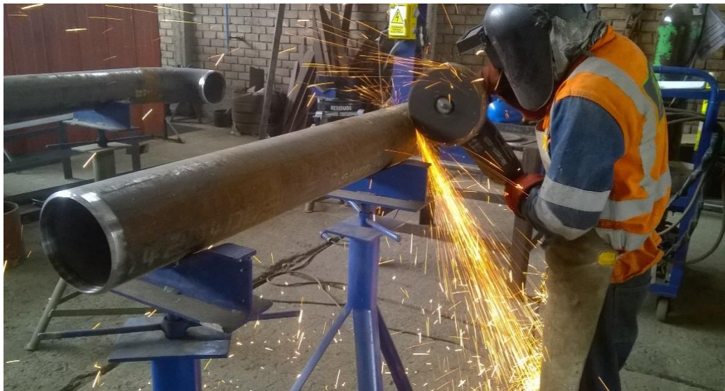
Figura 11 Proceso de corte de la tubería Fuente: ABG S.R.L.
