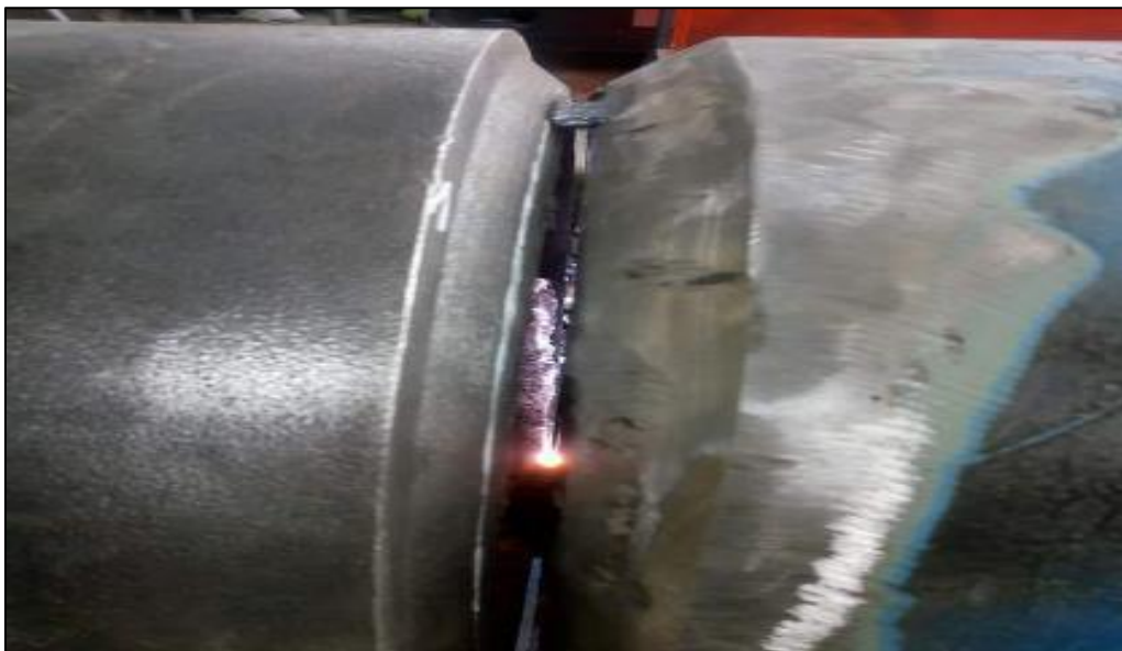
Figura 13 Proceso de armado y apuntalado. Fuente: ABG S.R.L.
