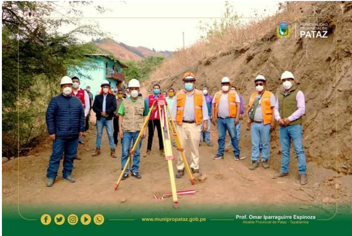
Figura 14: Colocación de la primera piedra con las autoridades y equipo técnico para el Servicio de mantenimiento periódico y rutinario del camino Vecinal Emp.PE-10C(Dv. San Andres) - Huancacalla - Emp.LI-127(Llampao).
