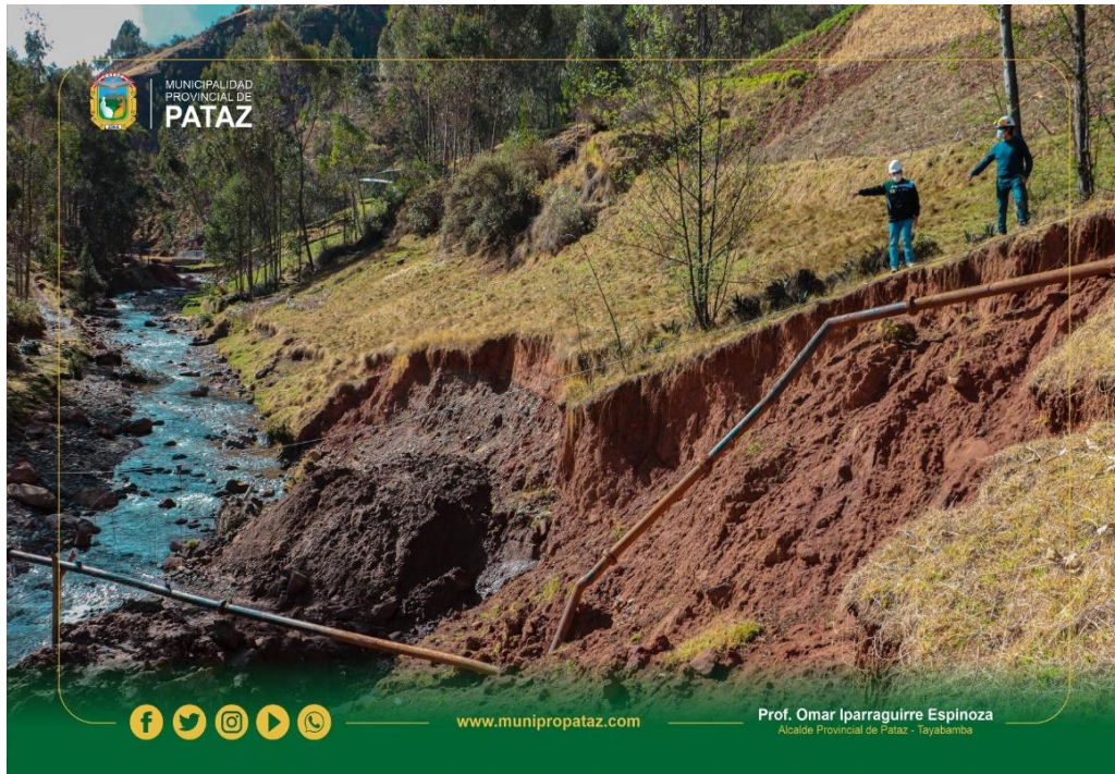
Figura 1: Pases aéreos de la línea de conducción de agua potable de Tayabamba.
