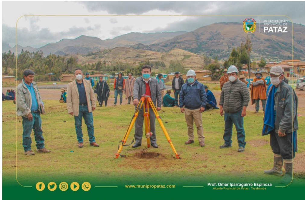
Figura 3: Mantenimiento del servicio básico de saneamiento en el anexo de Gochapita del distrito de Tayabamba
