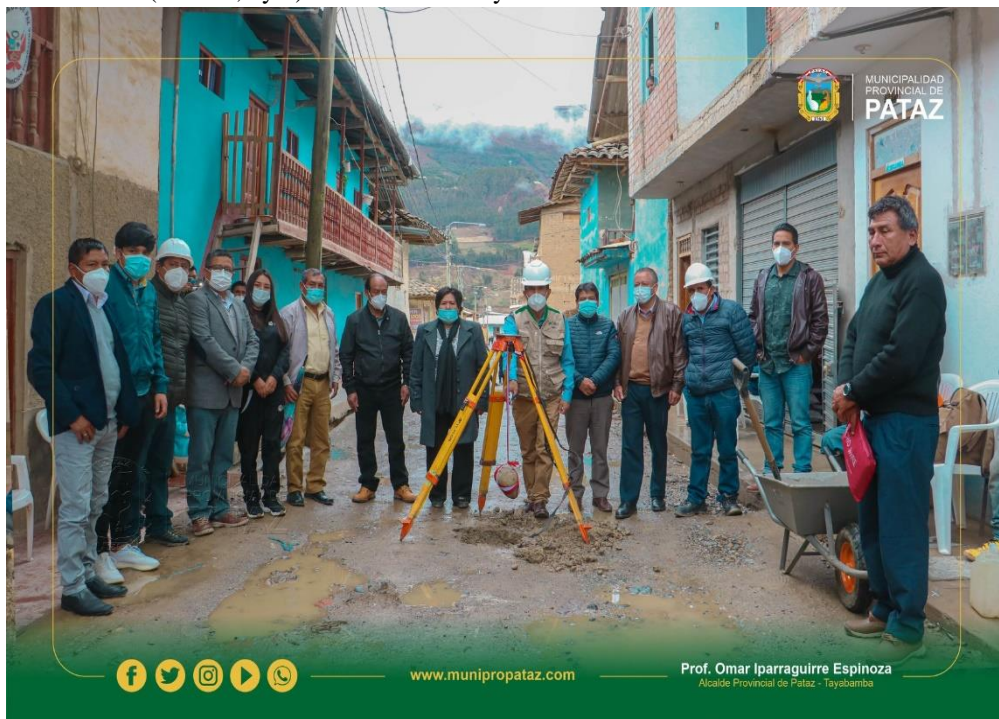
Figura 2: "Mejoramiento del servicio de transitabilidad vial y peatonal en el Jr. Enrique Marquina (Cdra. 1,2,3 y 4) y Jr. San Martín (Cdra. 1,2 y 3) del distrito de Tayabamba"
