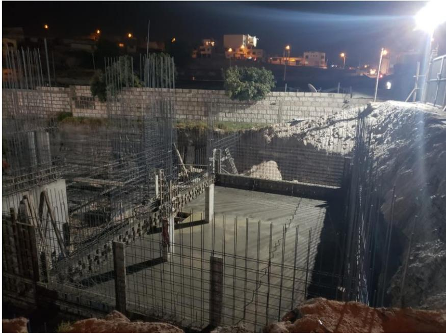
*Figura 11.* vaciado de concreto de losa de semisótano.
