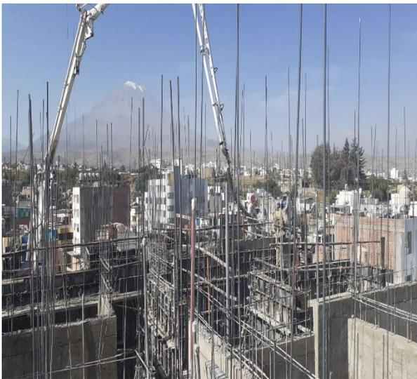
*Figura 30.* vaciado de concreto con bomba en piso 2.
