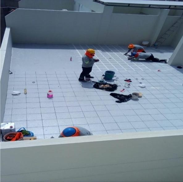
*Figura 28.* colocación de porcelanato en piso 2.
