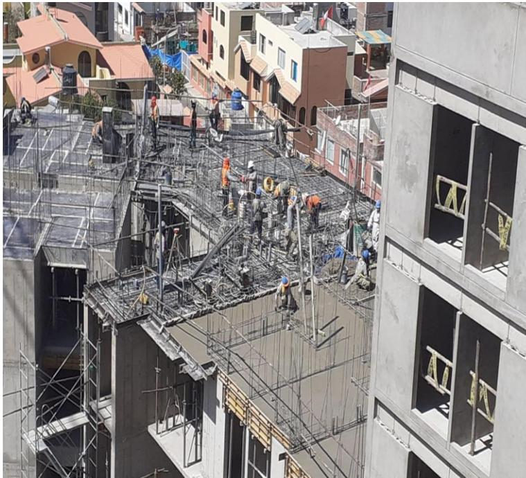
*Figura 14.* vaciado de concreto de losa de techo piso 3.
