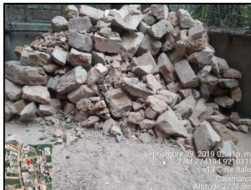
Figura 9: Almacenamiento de los residuos de construcción recolectados.
