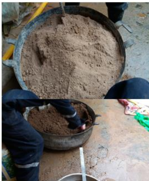
Figura 55: Mezcla adecuada para la elaboración de las unidades.
