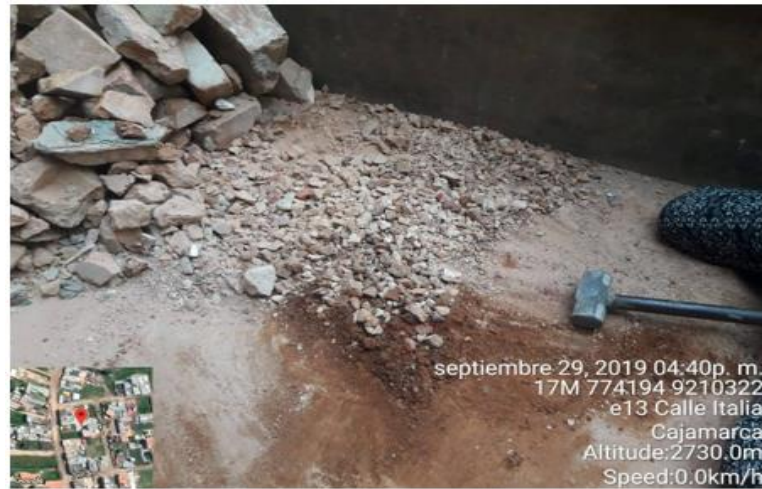
Figura 47: Realizando la demolición de los residuos de construcción.
