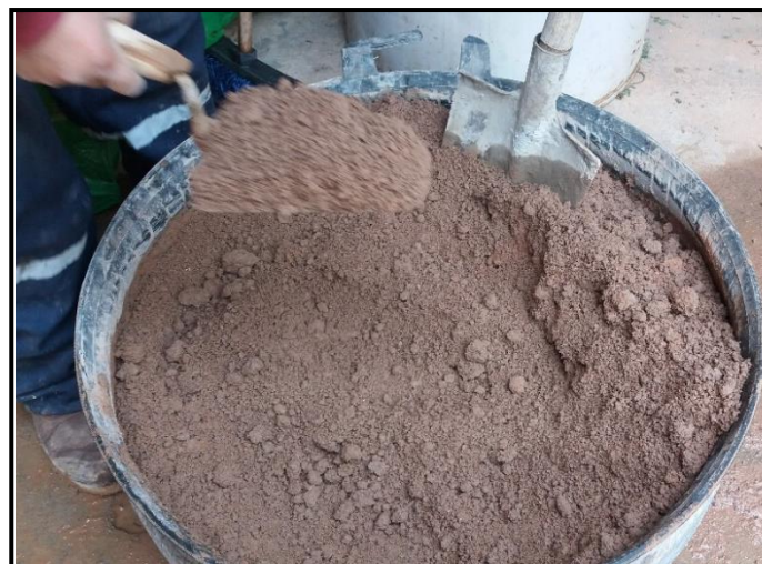
Figura 20: Mezclado de los materiales
