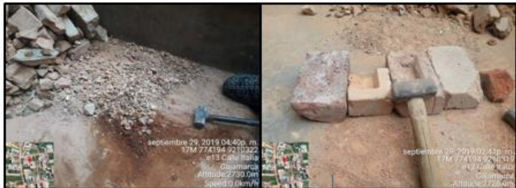
Figura 10: Demolición de los residuos de construcción.
