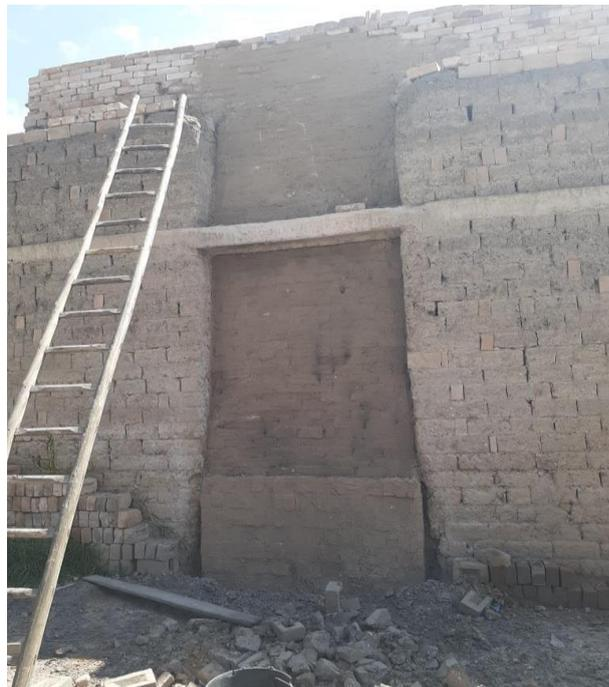
*Figura 22.* Horno cerrado para el proceso de la cocción
