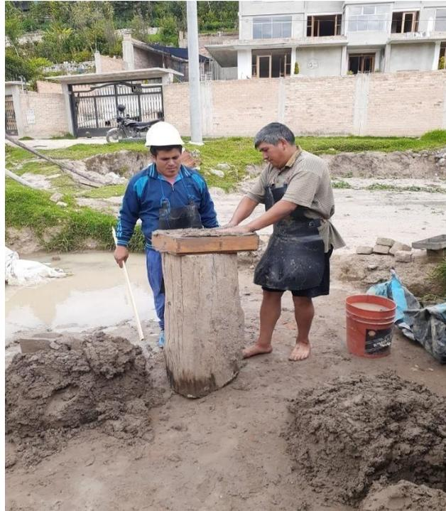
*Figura 17.* Moldeando los ladrillos
