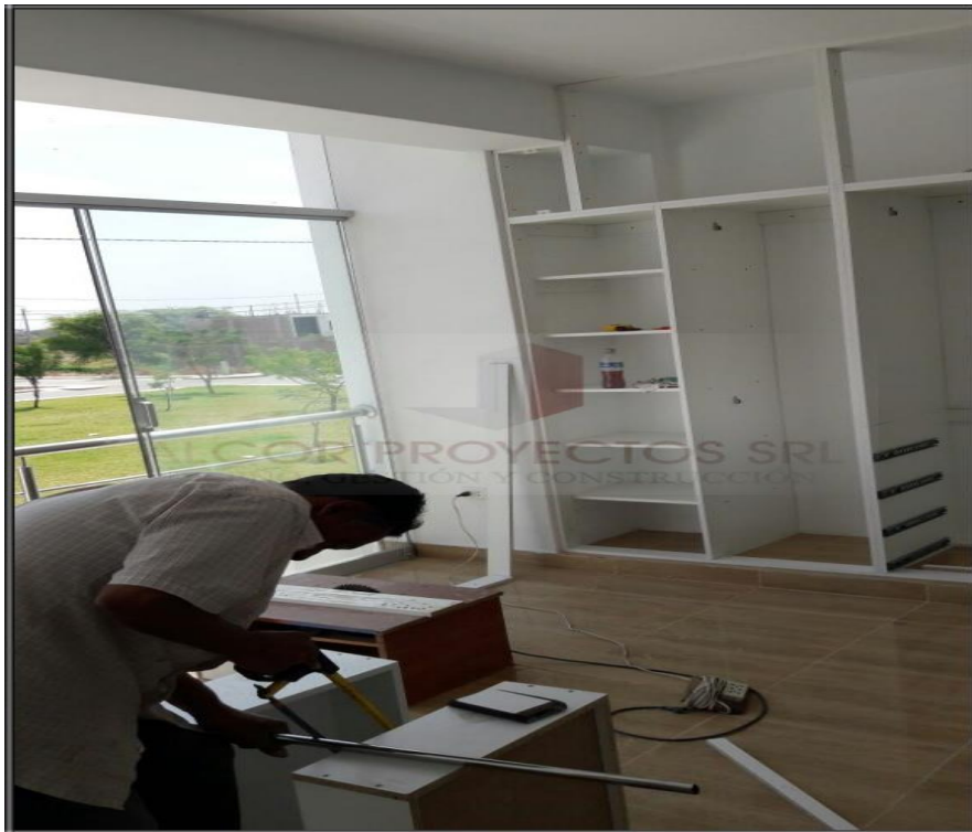
Figura 16. Instalación de accesorios en muebles de melamina.
