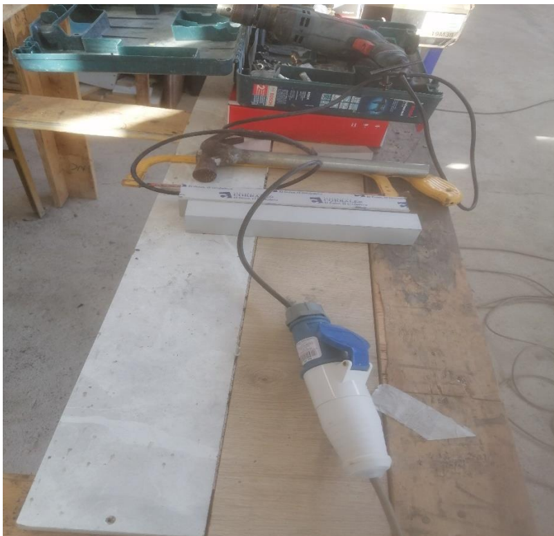
Figura 44. Cambio de enchufes industriales
