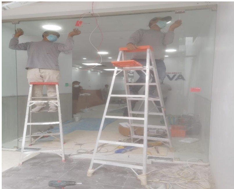
Figura 10. Proceso de instalación de mamparas
