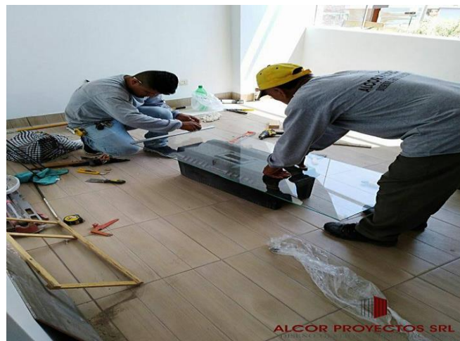
Figura 12. Proceso de instalación de accesorios
