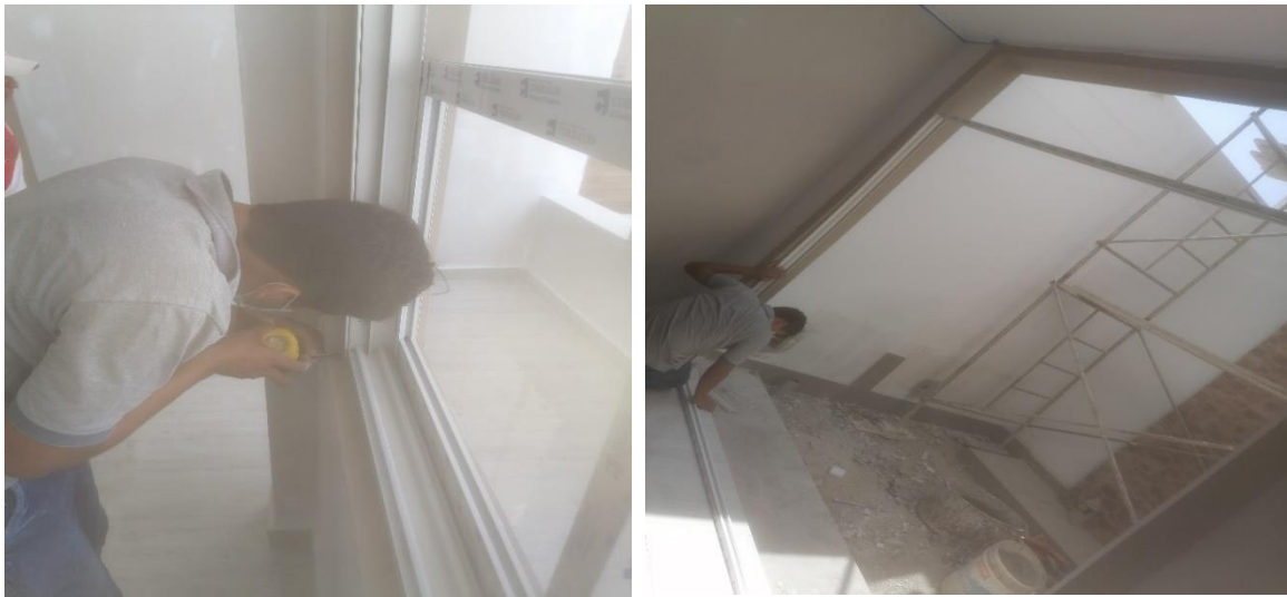
Figura 9. Proceso de instalación de marcos para ventanas y mamparas
