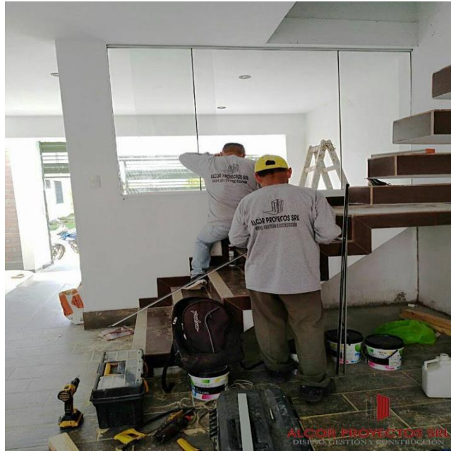
Figura 11. Proceso de instalación de ventanas
