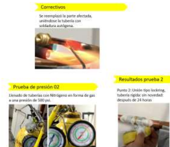
Figura N° 21. Correctivos prueba piloto -Unión de cobre libre de soldadura.
