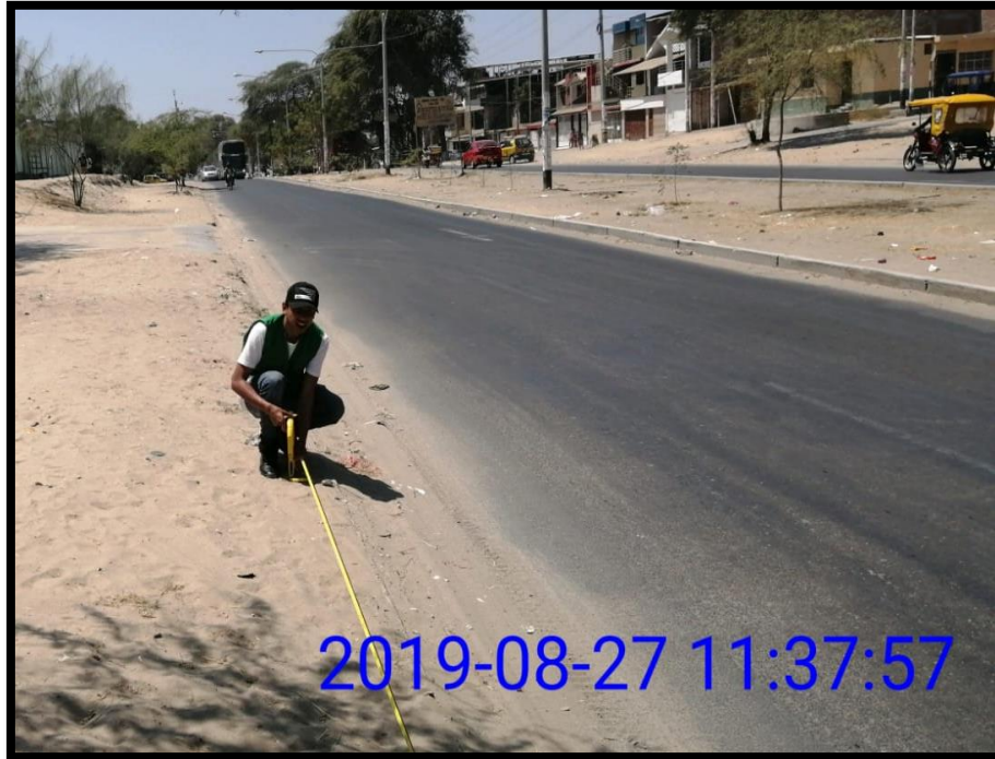
Figura 22: Medición de distancias para la ubicación de los equipos.
