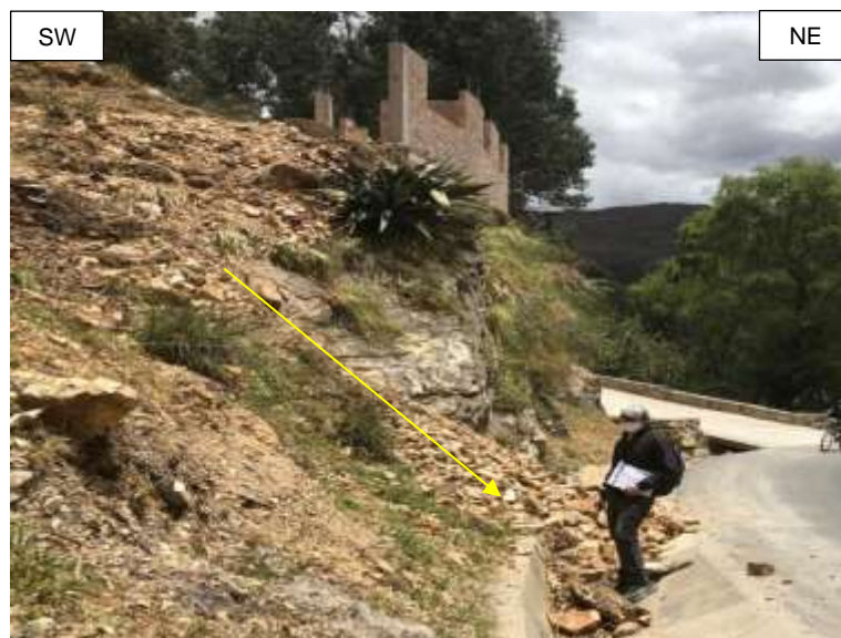
Figura 43: Deslizamiento de rocas cerca de la carretera N 9203574 E 783989 Cota 2600. Fuente: Propia
