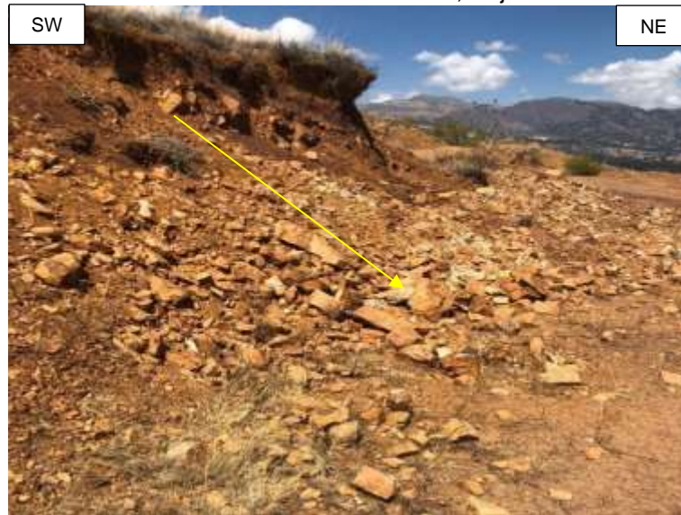
Figura 34: Caídas de rocas N 9204754 E 782065 Cota 2684. Fuente: propia
