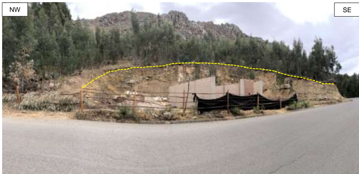
Figura 38: Deslizamiento rotacional de gran tamaño N 9204794 E 783258 Cota 2643. Fuente: propia
