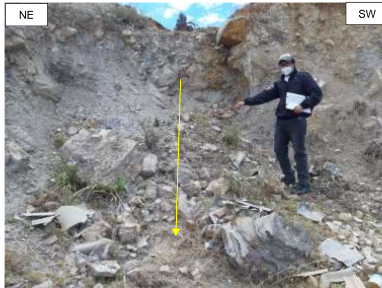
Figura 36: Caídas de rocas N 9204024 E 784938 Cota 2673. Fuente: propia
