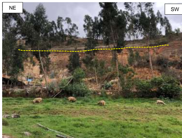
Figura 39: Deslizamiento traslacional N 9203408 E 784483 Cota 2608. Fuente: propia
