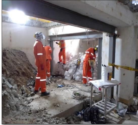
*Incorporación del acero de refuerzo para la cimentación, pedestales y muros de contención*
