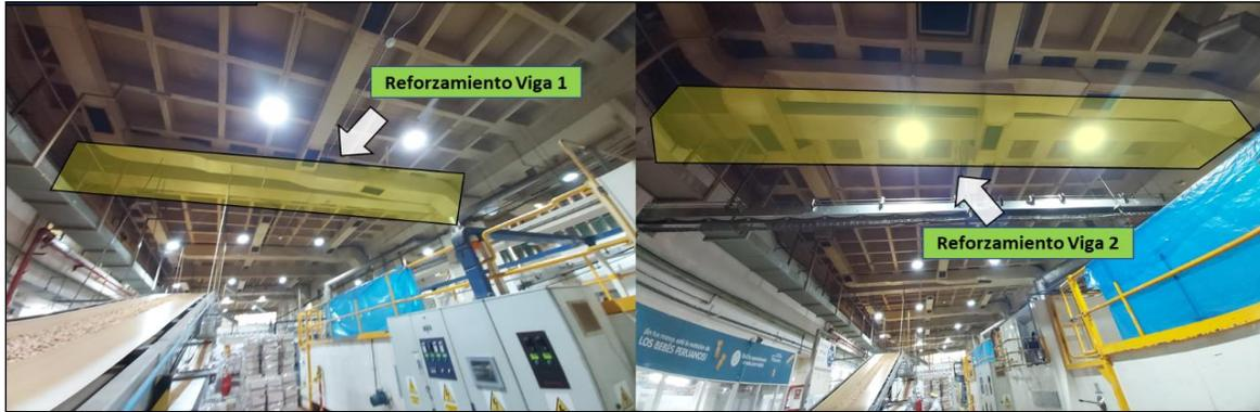
Además, Se requiere verificar los elementos estructurales (vigas y losa) de la losa de techo de Confitería donde se está proyectado ubicar nuevos equipos tales como: Amasadora, elevador, divisora boleadora, horno, encajonadora, artesas, etc. La losa se encuentra a 6.50m desde el nivel del primer piso.
