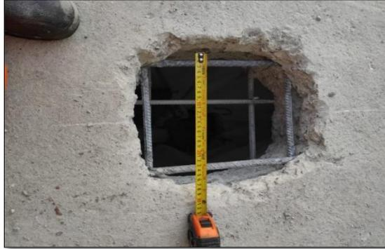
Posteriormente, se realizó la verificación del acero de refuerzo usando el equipo Profoscope en la zona superior e inferior.
