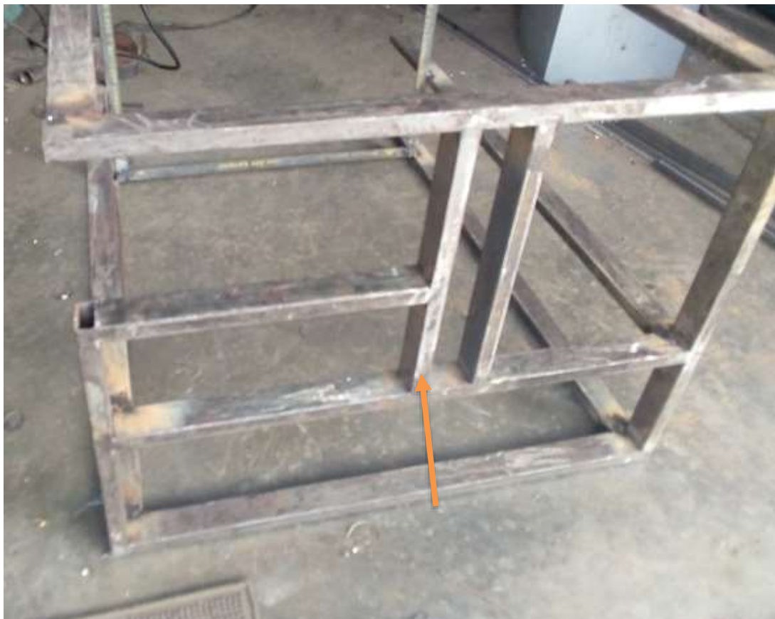
Figura 25. Carga puntual en la base de la estructura. En esta imagen tenemos la estructura inferior, compuesta por tubos rectangulares. Después de ser soldada.
