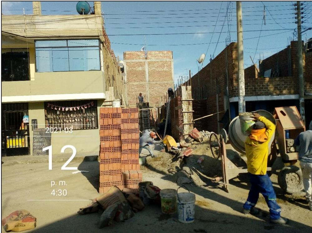
Fotografía 11. Tipo de mezclado utilizado en la obra de autoconstrucción 09.
