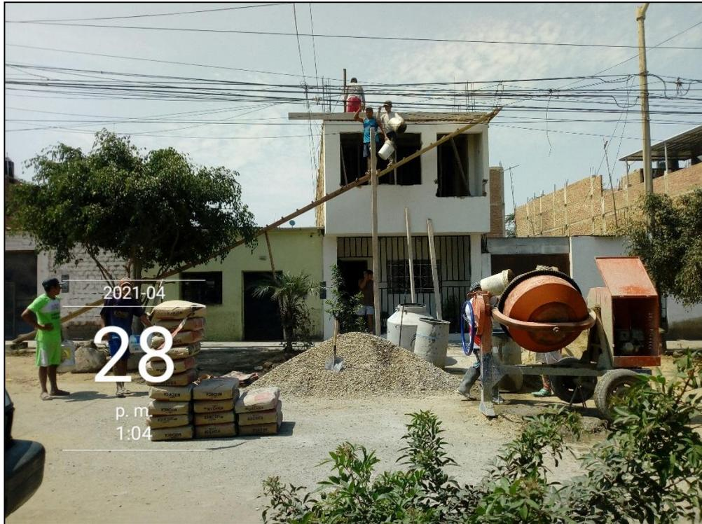
Fotografía 13. Tipo de mezclado utilizado en la obra de autoconstrucción 16.
