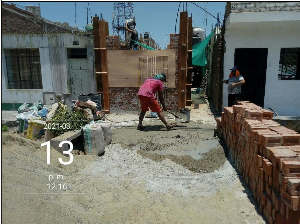
Fotografía 12. Tipo de mezclado utilizado en la obra de autoconstrucción 11.
