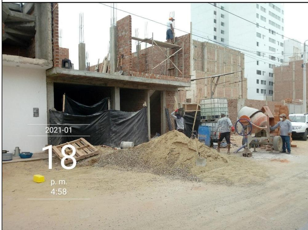
Fotografía 10. Tipo de mezclado utilizado en la obra de autoconstrucción 01.
