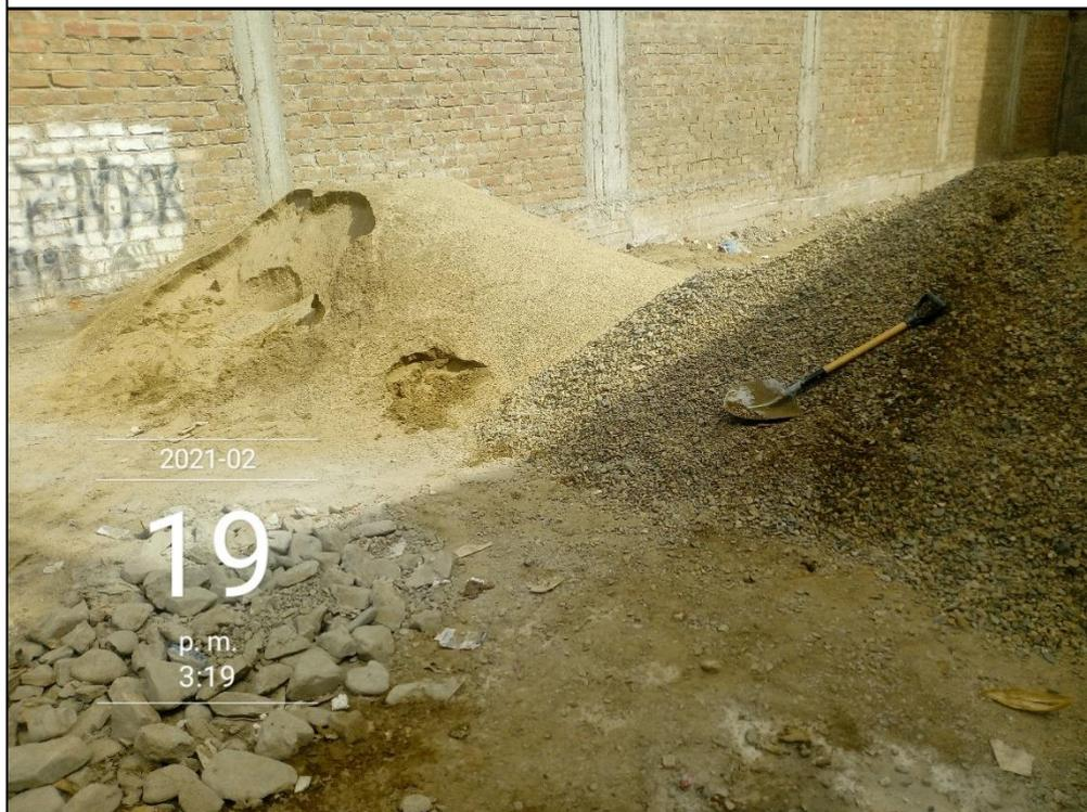
Fotografía 14. Método de almacenaje del agregado, montículos al aire libre. AC – 06.
