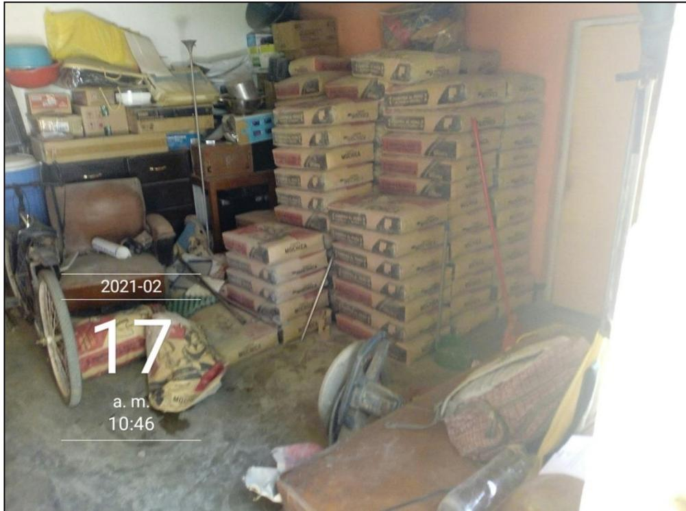
Fotografía 15. Método de almacenaje del cemento, pilas bajo techo. AC – 05.
