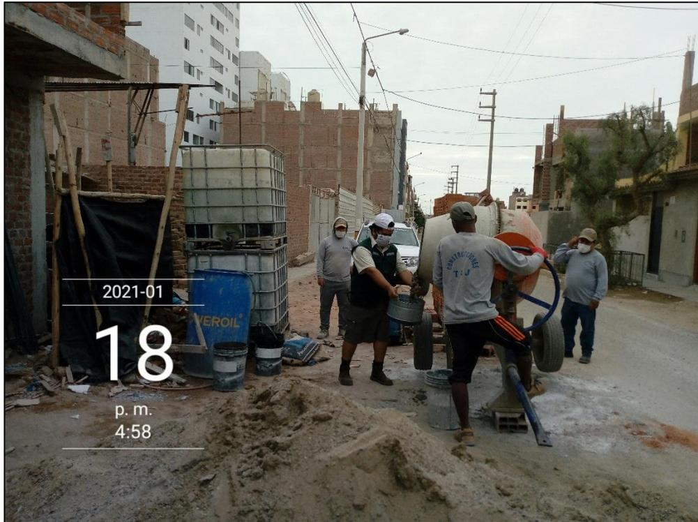
Fotografía 19. Toma de muestra (30 Kg) del concreto. AC – 01.
