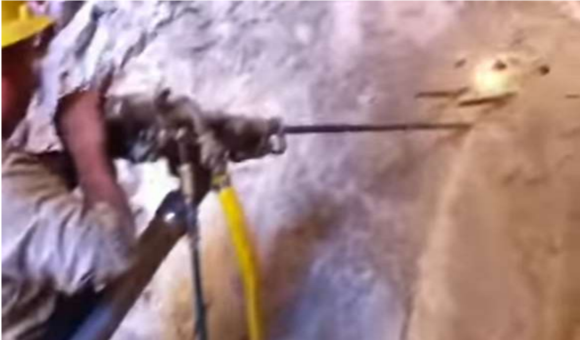
Foto 7. Máquina Jack Leg utilizada en la perforación.
