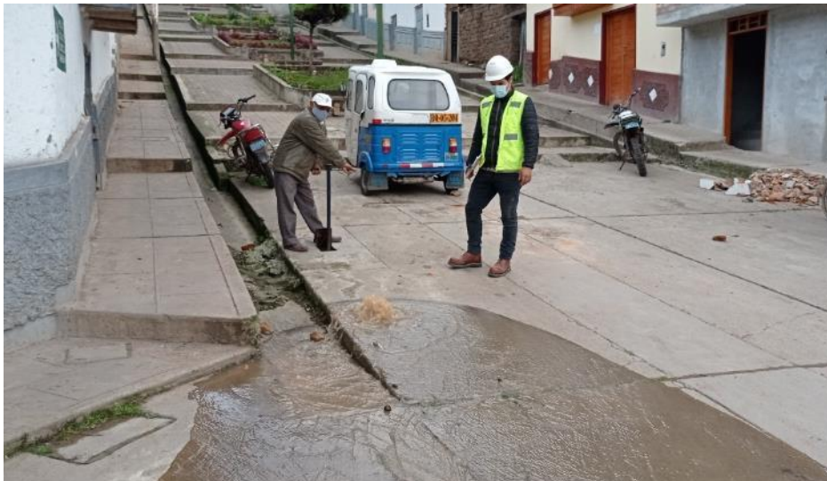
Fotografía 8 Prueba de funcionamiento de una válvula de purga de la red de agua Las Tercianas.
