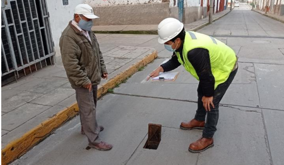
Fotografía 7 Inspección a las llaves de repartición de la red de agua Rosapampa.
