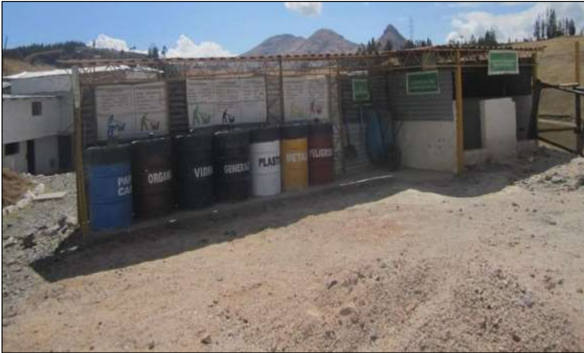
Figura 25. Zona de almacenaje de residuos sólidos.
