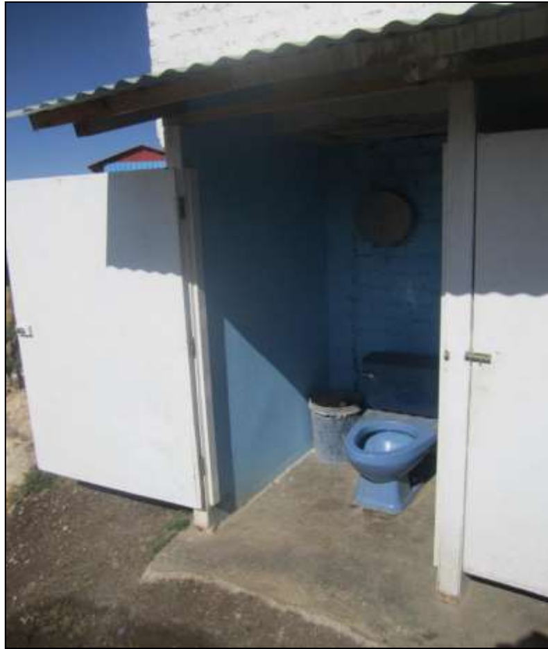
Figura 37. Baños de los trabajadores.
