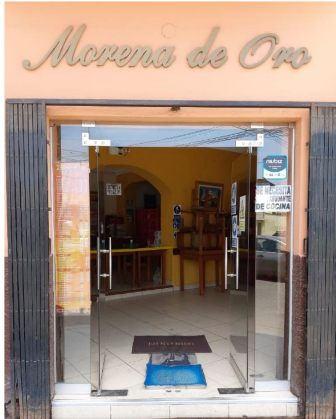
Figura 1. Fachada de la empresa Morena de Oro SRL.
