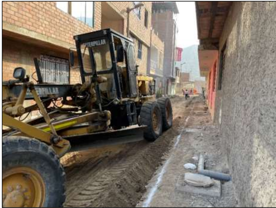
Figura 9 trabajo de batido y nivelación del afirmado
