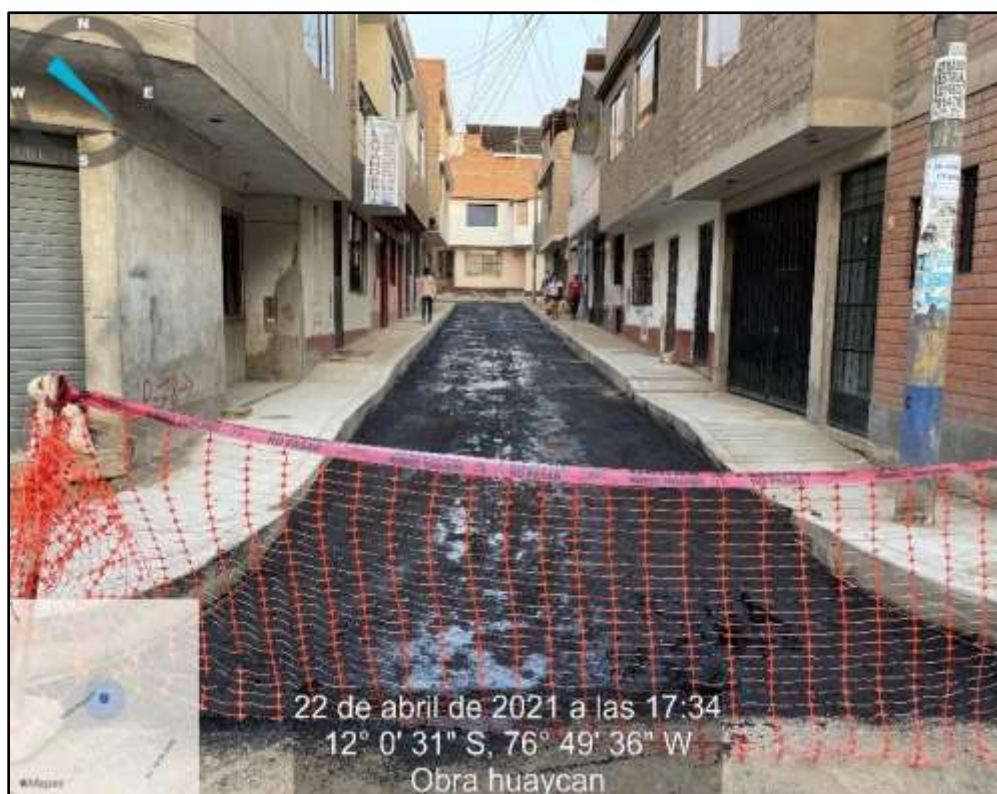
Figura 11 Imprimación asfáltica
