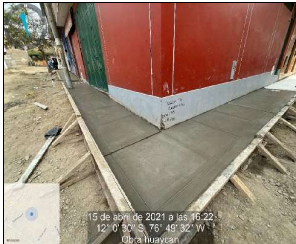
Figura 14 Encofrado de veredas de concreto
