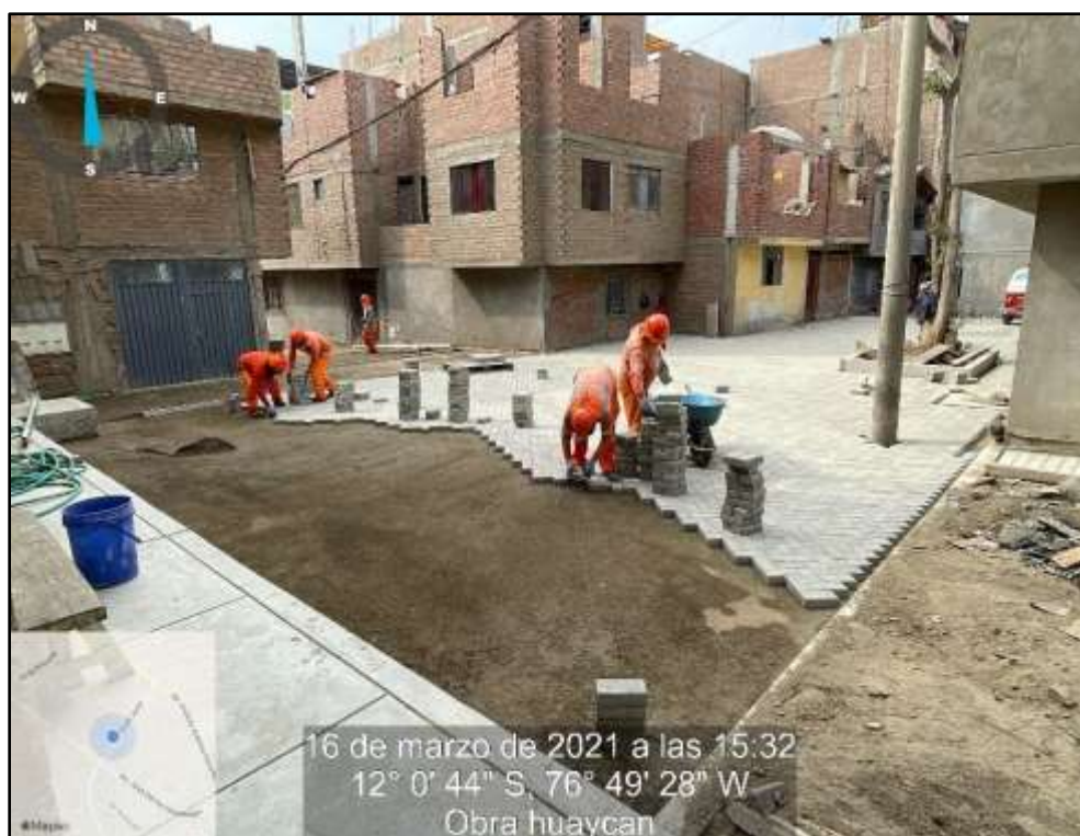
Figura 13 Colocación del adoquinado de concreto E = 6.00 cm
