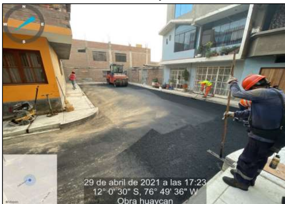
Figura 12 Carpeta asfáltica en caliente E = 5.00 cm
