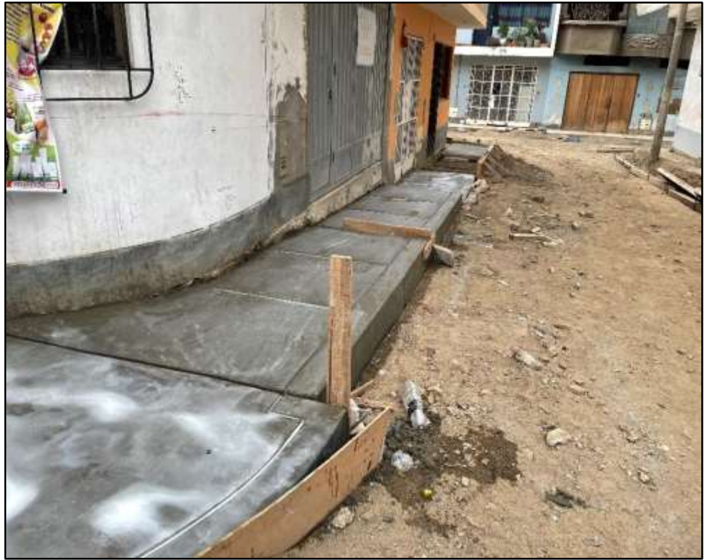
Figura 15 Desencofrado y Curado de Veredas de Concreto
