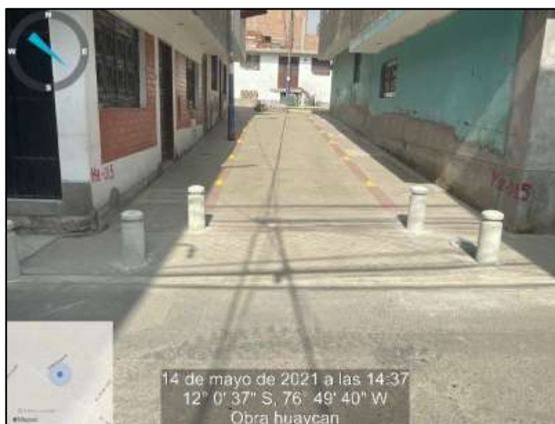
figura 20 Instalación de Boyas y Bolardos de Concreto
