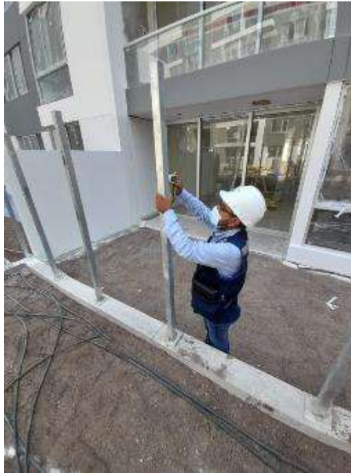
Figura 29. Inspección del espesor de micras
