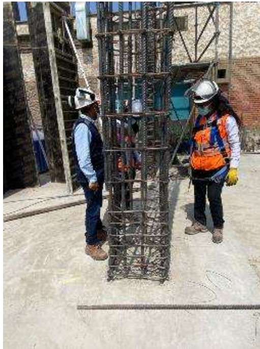
Figura 25. Liberación de armadura de acero en columna
