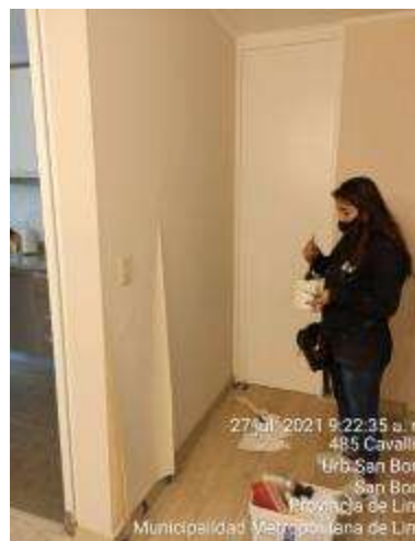
Figura 44. Papel se desprende del sustrato
