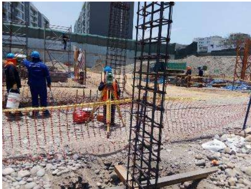
Figura 26. Verificación de ubicación de la columna
