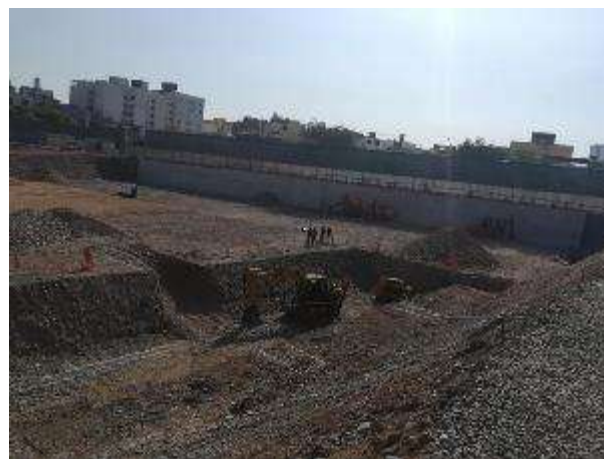
Figura 22. Excavación de cisterna
