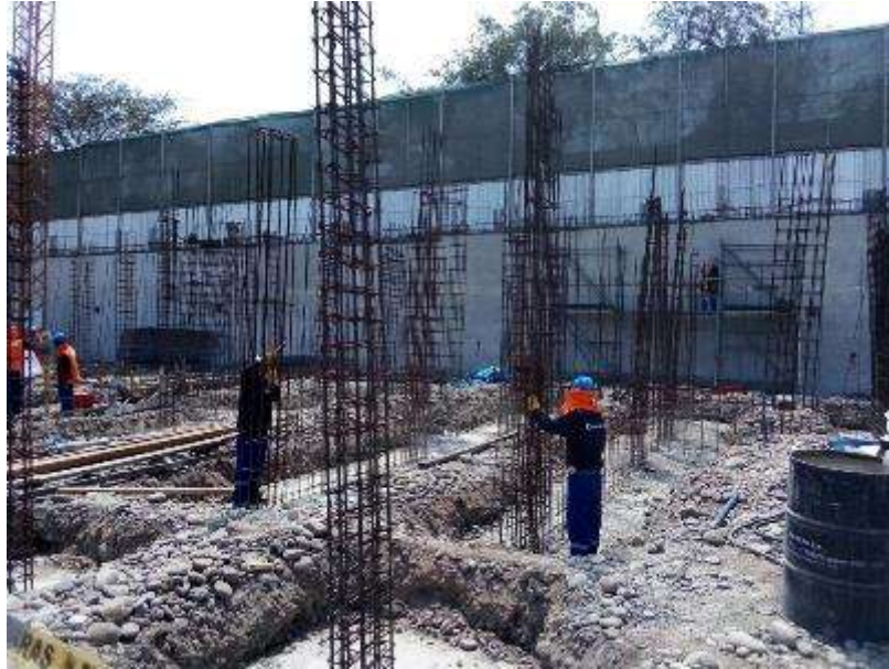
Figura 27. Montaje de acero prearmado
