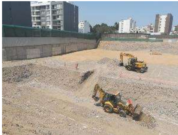
Figura 21. Excavación de plataformado
