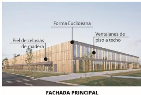
Fábrica de calzado que cuenta con una escuela de producción en cuero, es por ello que plantea una envolvente con celosías de madera que influyen en el control de ventilación natural utilizando ventanales de piso a techo, además de adaptarse a un entorno natural.
