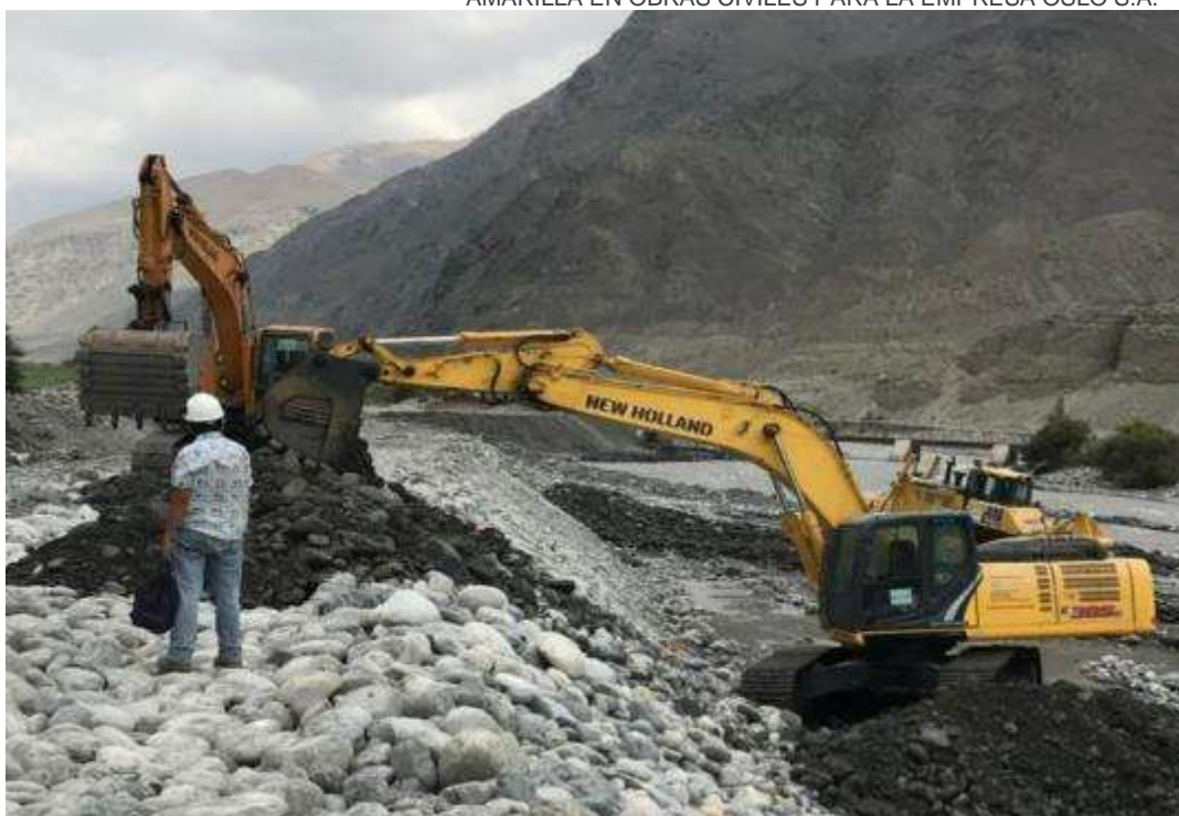
Figura 12. Ejecución de proyecto – Descolmatación de Río Pativilca – Dirección Regional de Agricultura 15-02-2018.
