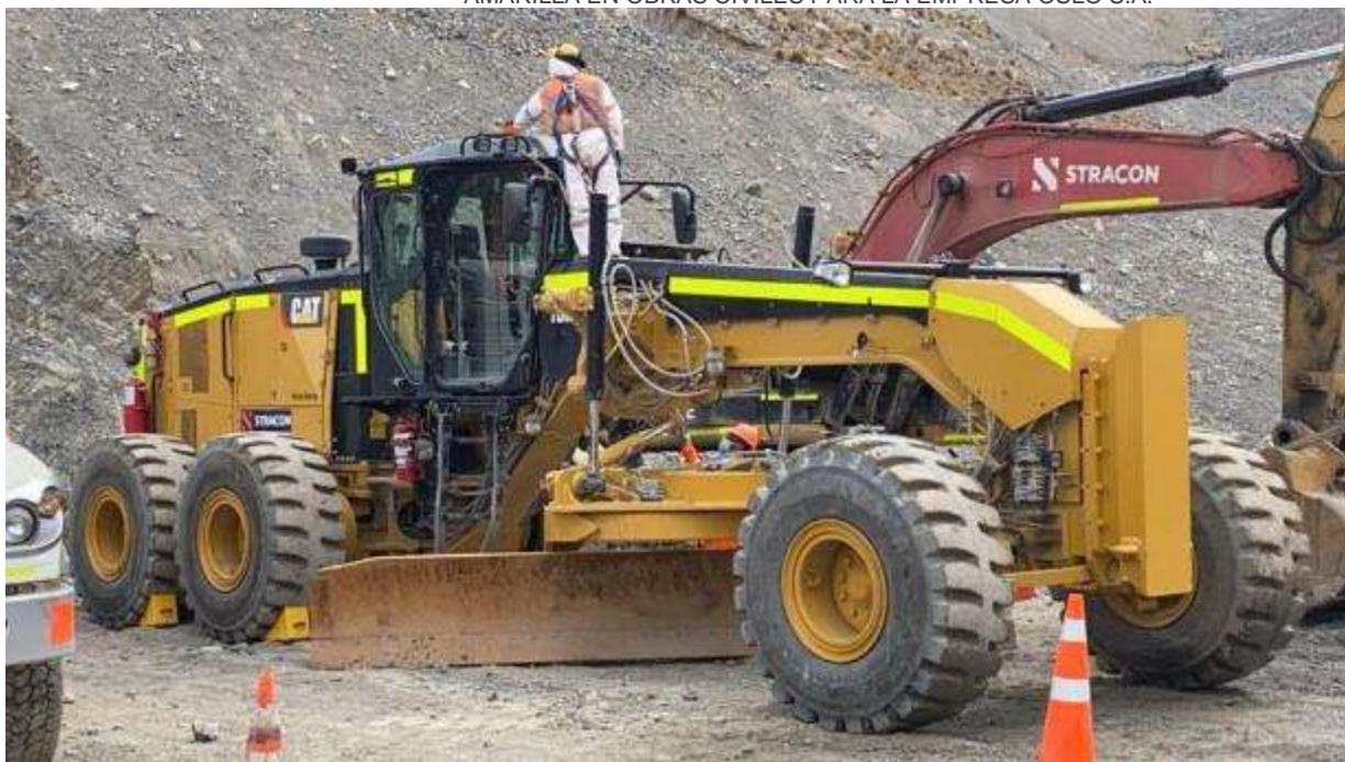
Figura 16. Taller de Mantenimiento - 4° Etapa de la ampliación de la presa de relaves de la Minera Chinalco Perú S.A. 12-07-2021.
