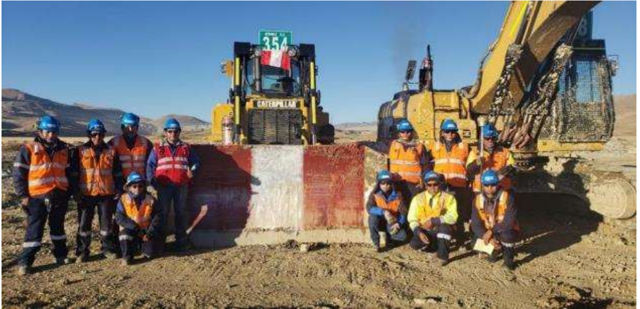
Figura 14. Ejecución de proyecto – Cierre de la presa de relaves Ccamacmayo Fase 5, Mantenimiento de vías y contrato Marco – en la compañía Minera Antapaccay 06-05-2019.
