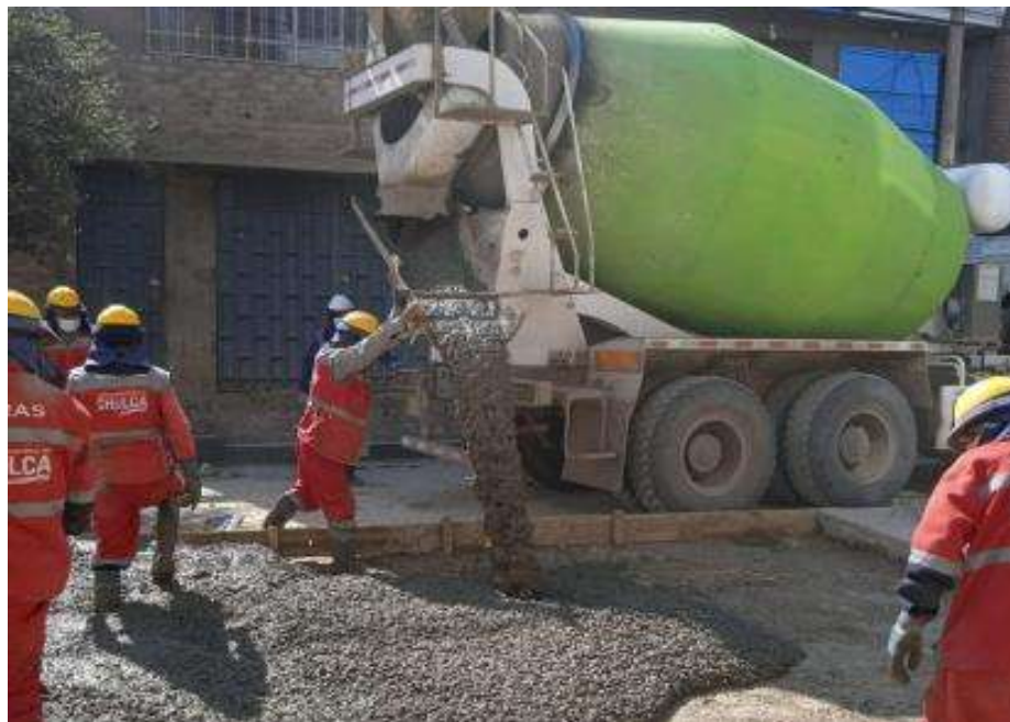
Figura 7. OSLO S.A. brinda servicios de vaciado de concreto, Municipalidad Provincial de Huancayo – Asfaltado de calles 2020.
