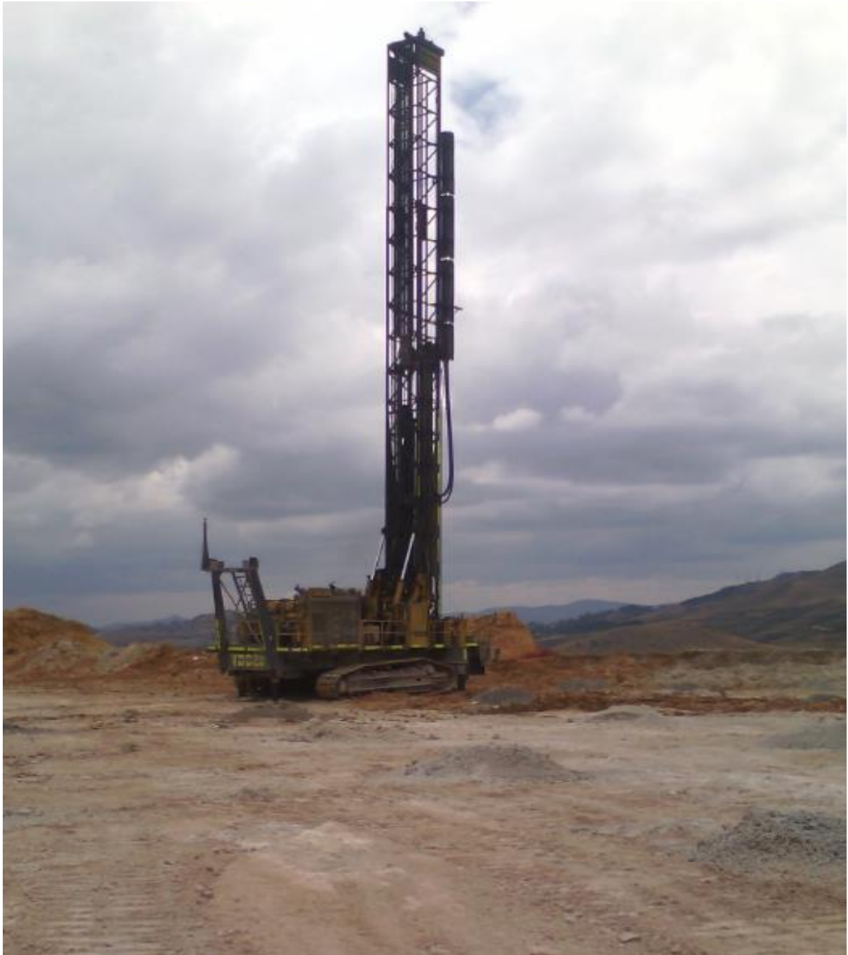
Foto 3: La Perforadora Pit Viper perforando de los taladros de producción.
