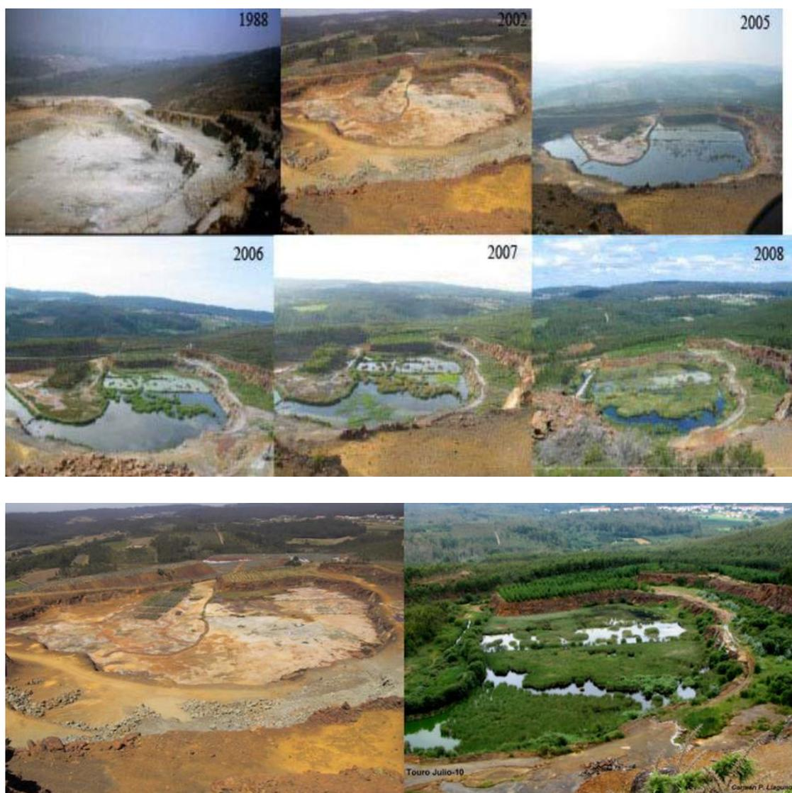
*Figura 2:* Evolución de la recuperación de la mina Tauro con Tecnosoles reactivos y un humedal de condiciones subóxicas.
