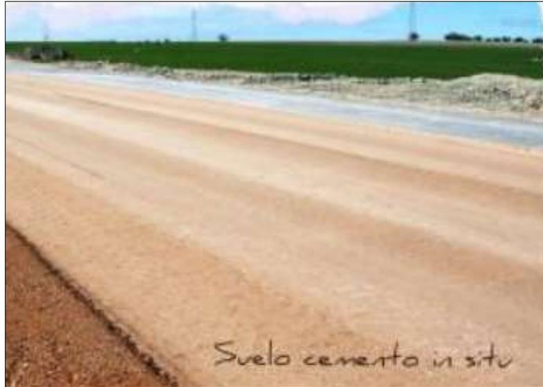
*Figura 4: Uso de suelo-cemento en sub bases de pavimentos.*
