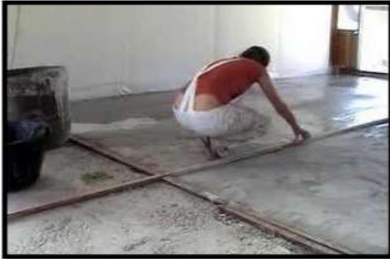
*Figura 18: Piso o falso piso de suelo-cemento compactado y terminado.*
