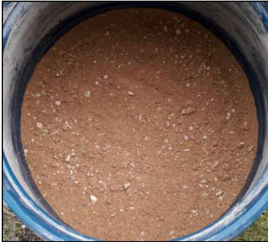
*Fotografía 13: Colocación de séptima capa Filtro – Arena Gruesa*
