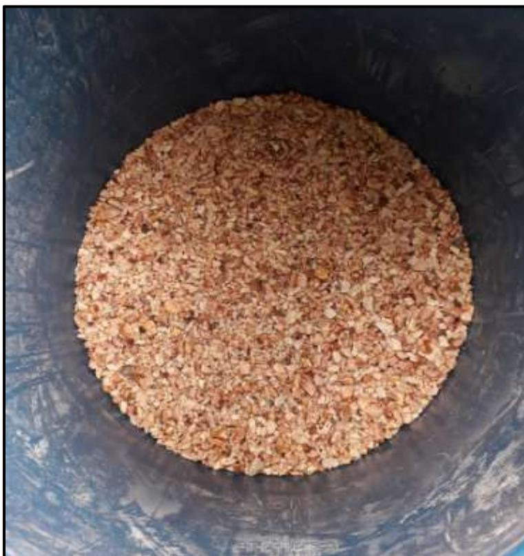
**Fotografía 8:** Colocación de tercera capa Filtro - Confitillo
