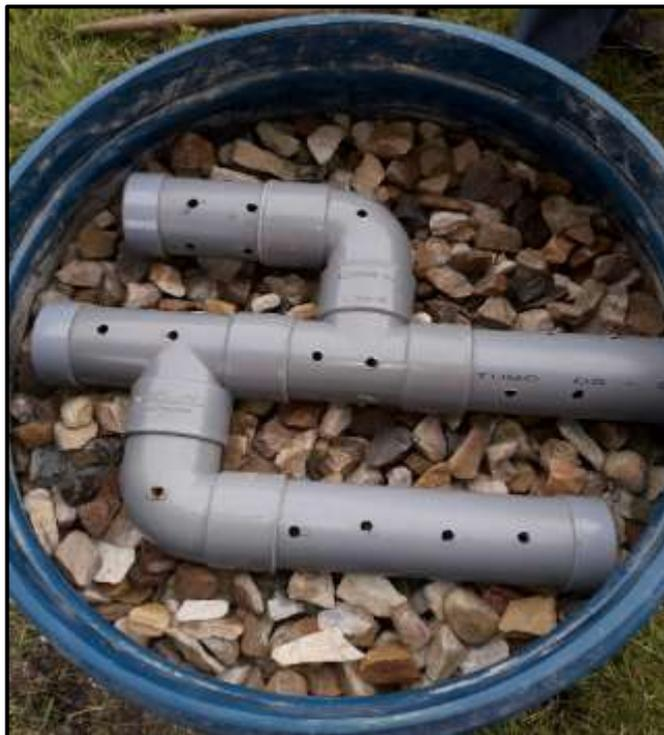
*Fotografía 15:* Colocación de tubería agujerada para ingreso de agua
