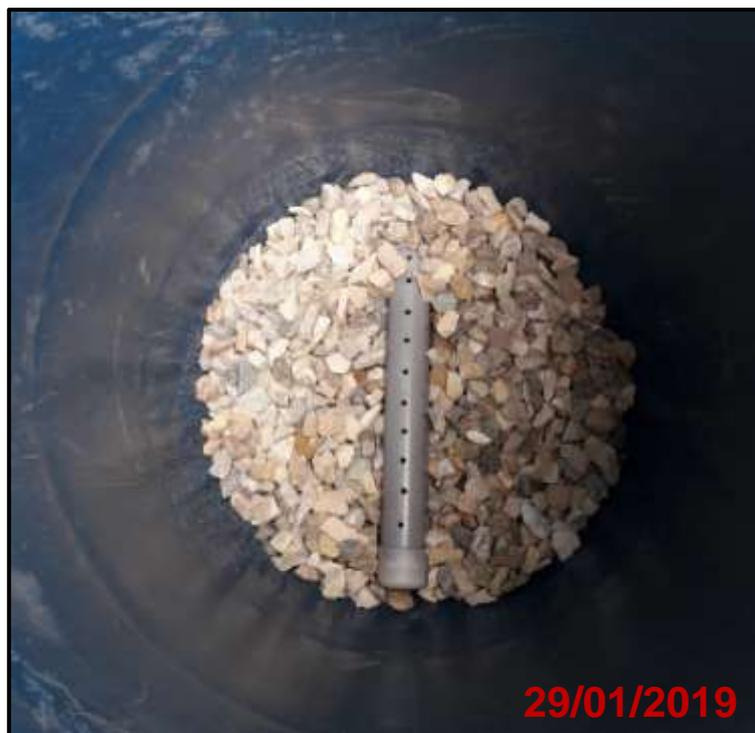
*Fotografía 6:* Colocación de primera capa Filtro – Base - Gravilla de 3/4"
