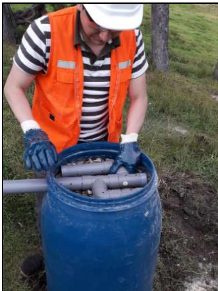
*Fotografía 16:* Ensamblado final de tubería al filtro
