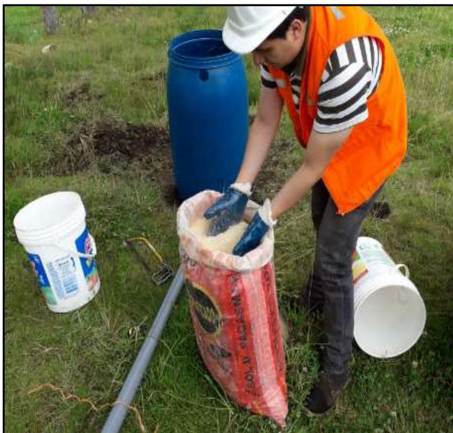
*Fotografía 10:* Colocación de aserrín al filtro
