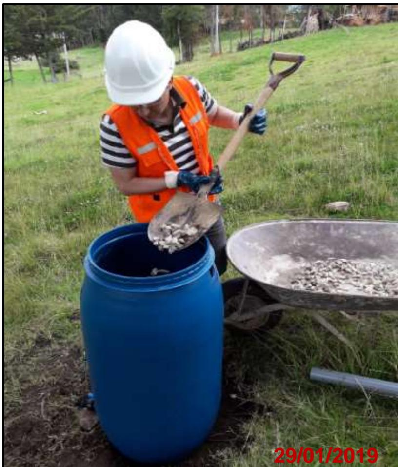
*Fotografía 5:* Colocación de estratos al filtro
