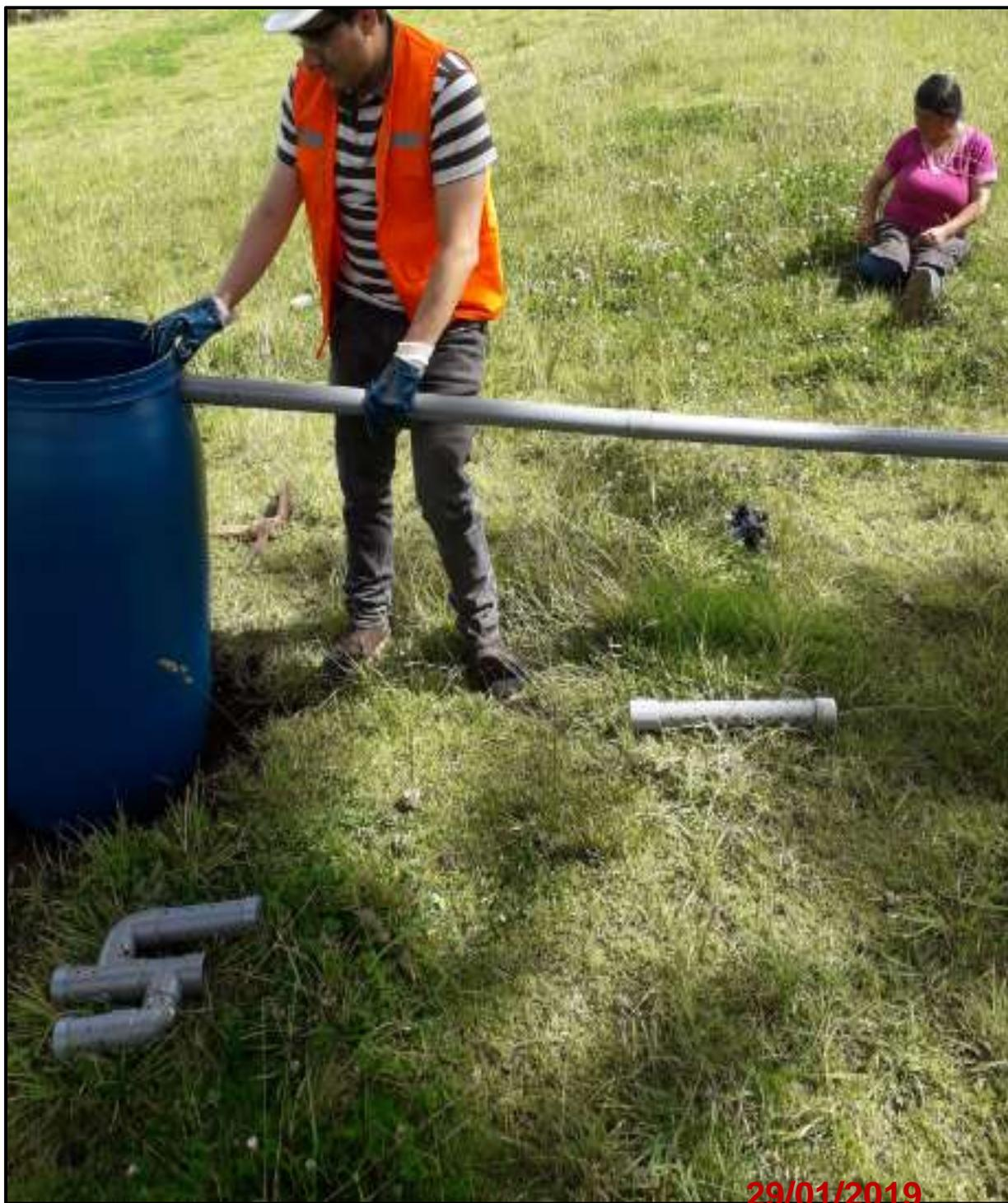
*Fotografía 2:* Ensamblado de tubería - Ingreso de agua
