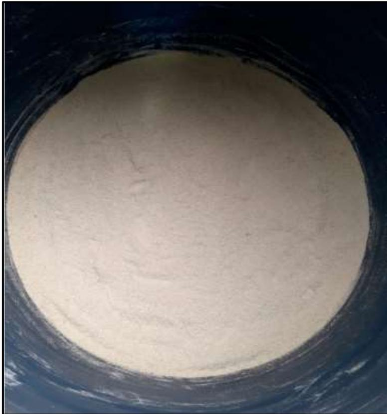
*Fotografía 11:* Colocación de quinta capa Filtro – Aserrín
