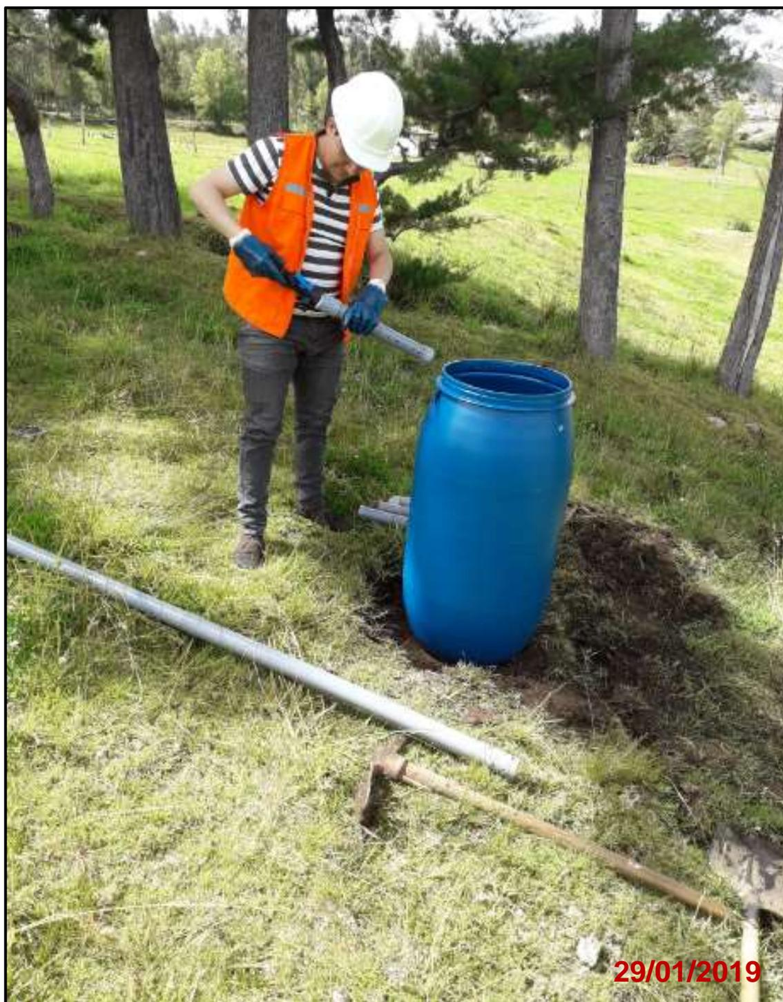
*Fotografía 3:* Ensamblado de tubería agujereada - Salida de agua
