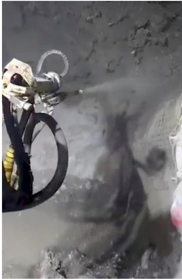
Lanzado de shotcrete con cemento tipo IP
