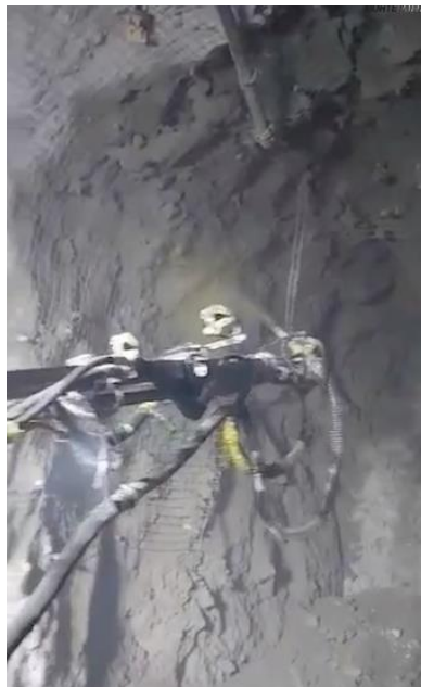
Lanzado de shotcrete con Plastol
