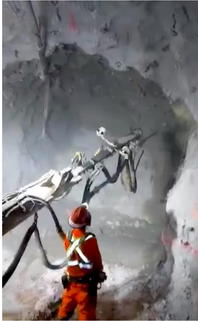
Lanzado de shotcrete con Plastol
