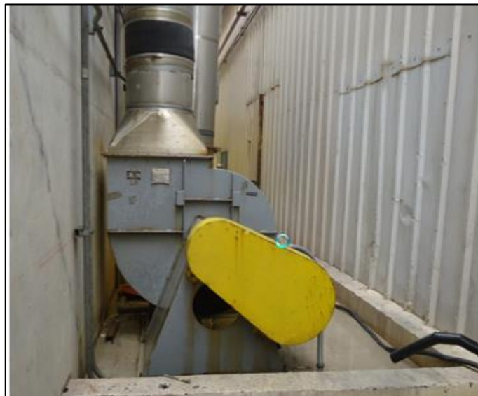
Figura 28: Extractor de 30 Hp en Consorcio Minero Horizonte.
