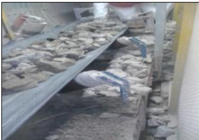
Figura 11. Caída de rocas en las fajas.
