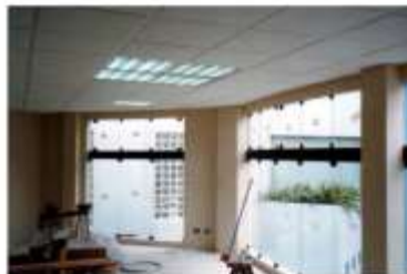
Falso cielo raso
