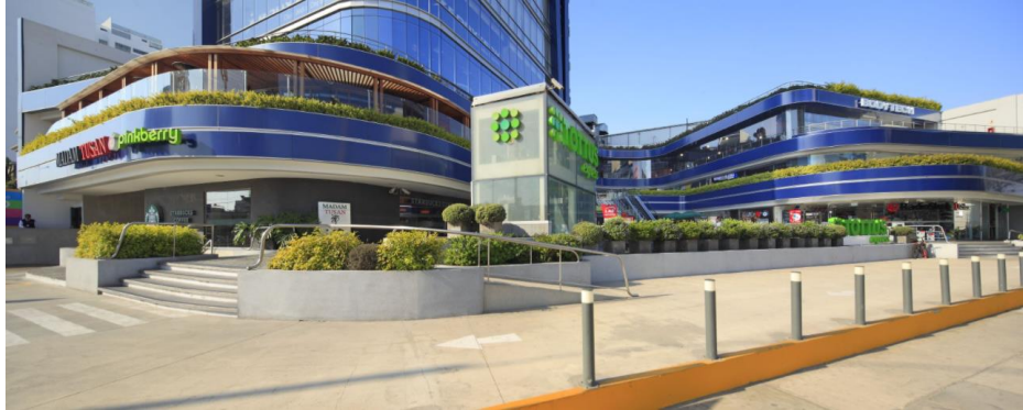
Figura N° 8. Vista superior del Centro Comercial Paso 28 - Perú
