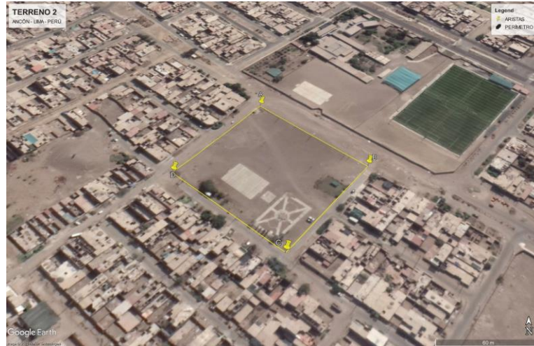
Figura N° 40. Vista aérea del terreno N.º2
