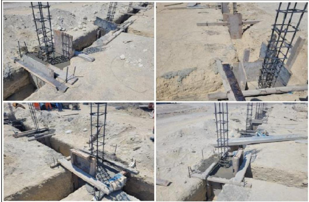
Figura 50. Zapatas aisladas de la viga de cimentación
