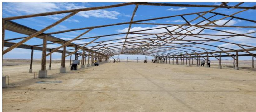
Figura 30. Instalación de tijerales y armadura
