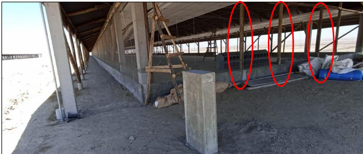
Figura 35. Pórtico de Galpón con columnas de palo y base de concreto
