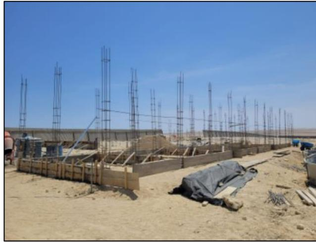
Figura 54. Encofrado de sobrecimiento para vaceado monolítico
