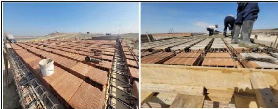
Figura 56. Techado y vaceado de losa aligerada
