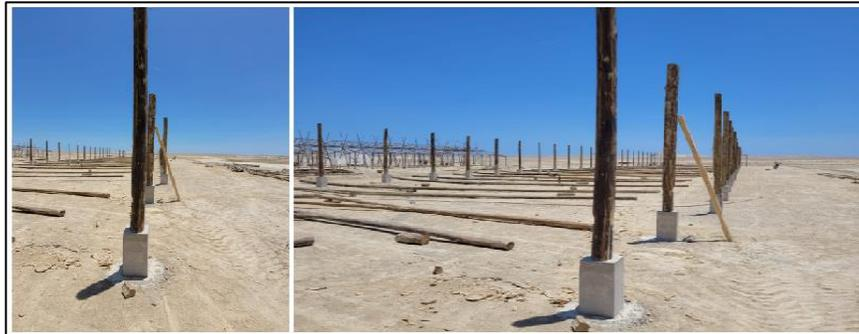
Figura 29. Desalineamiento del trazo lateral
