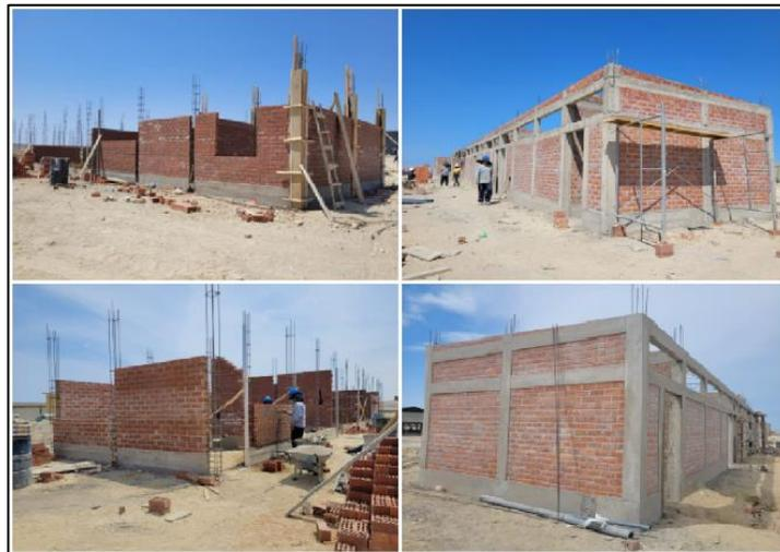
Figura 55. Levantamiento de muros, vigas y columnas
