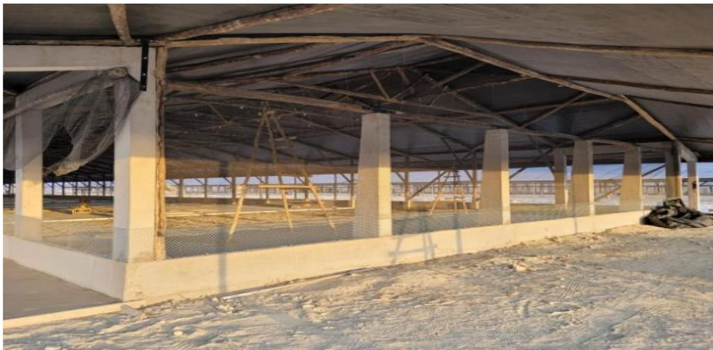
Figura 37. Pórtico de galpón con columnas de concreto
