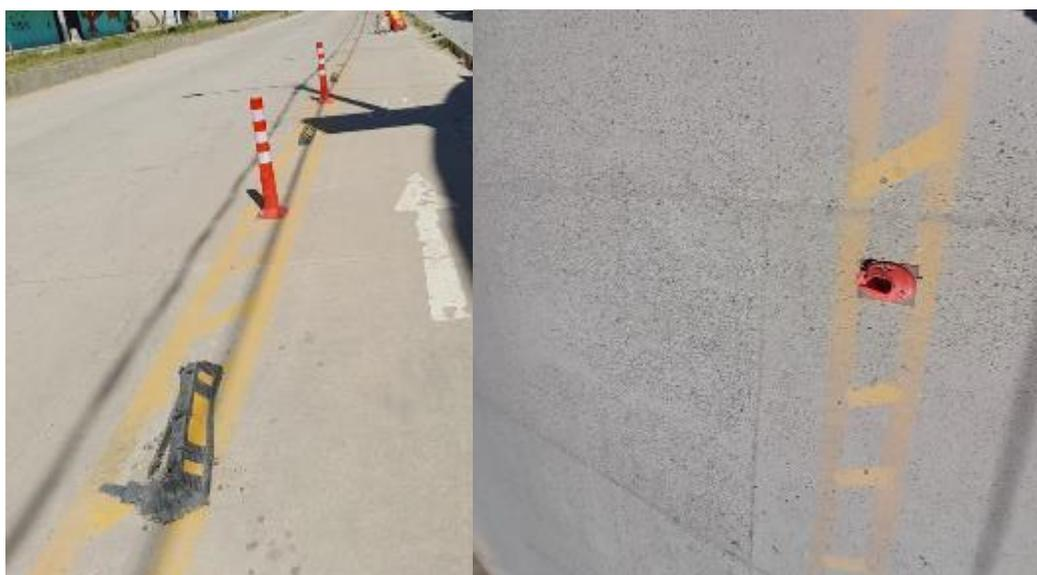
**Figura 38:** *Deterioro de elementos de segregación.*
