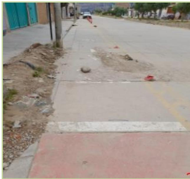
**Figura 35:** Falta de mantenimiento en la ciclovía.
