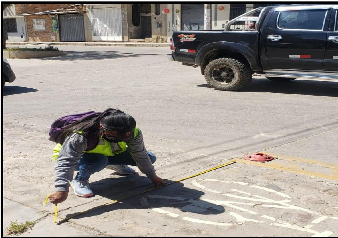
Foto N° 5: Verificación del ancho de confinamiento de la ciclovía.
