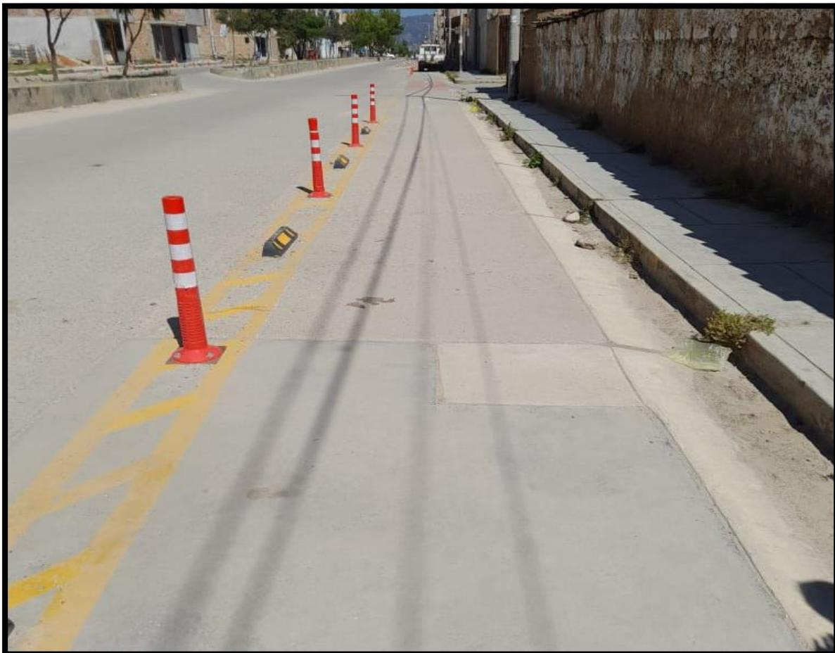
Foto N° 7: Verificación técnica del tipo de segregación en la ciclovía.
