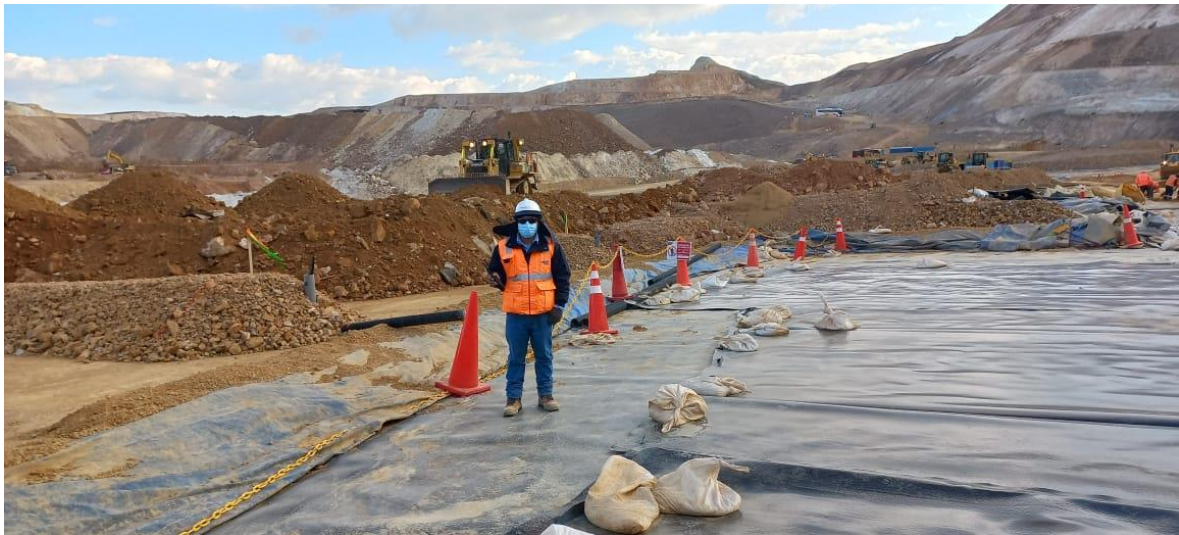
Foto 2. Vista de Tractor D6, empujando material PL en área de labor.
