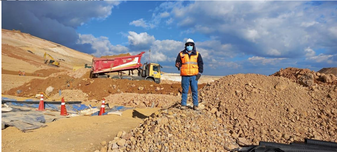
Foto 3. Vista en campo de descarga de material Soil Liner en un modelo de volquete.
