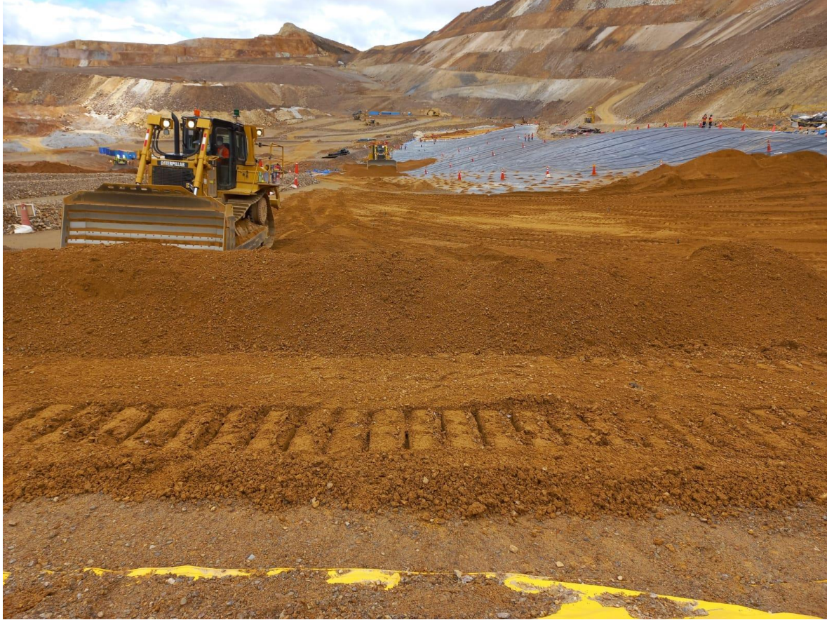
Foto 5. Tractor D6 empujando material PL.
