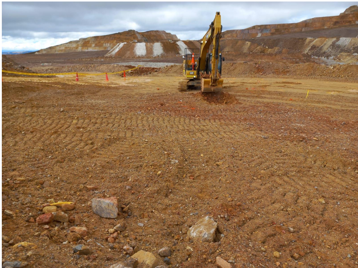
Foto 4. Excavadora colocando material PL.
