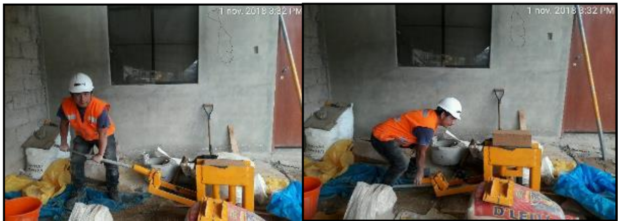
Fotografía N° 15. Extracción del ladrillo fabricado con la maquina CINVA RAM.
