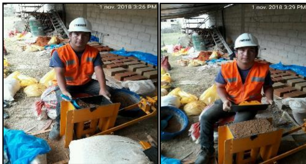
Fotografía N° 13. Llenado del material a la maquina CINVA RAM.
