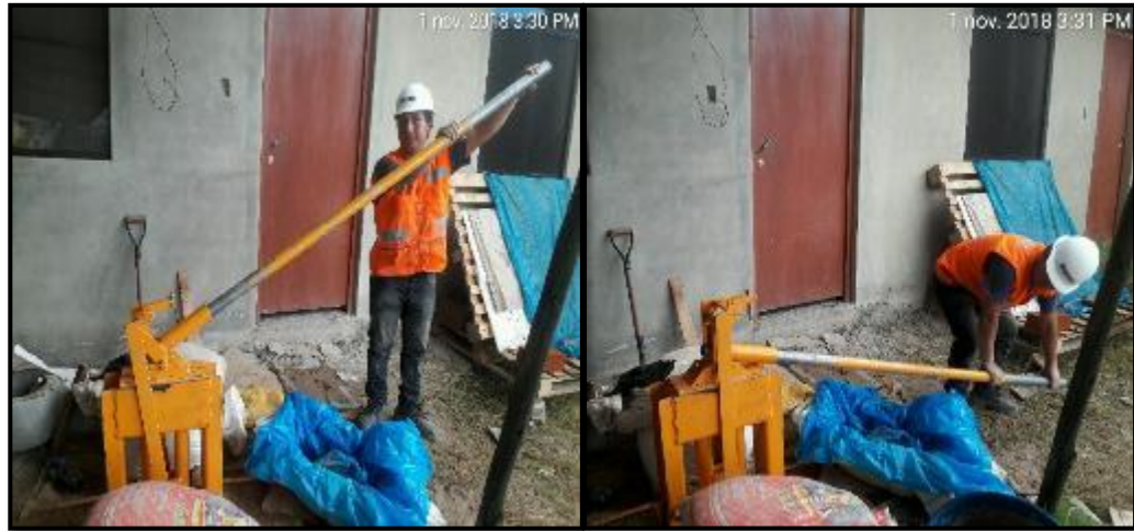
Fotografía N° 14. Fabricación y compactación del ladrillo con la maquina CINVA RAM.
