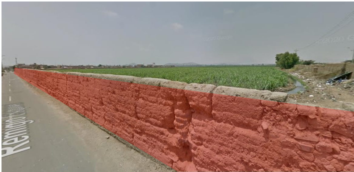
Fig. 39: Vista del terreno 3 desde la calle Remigio Esquivel
