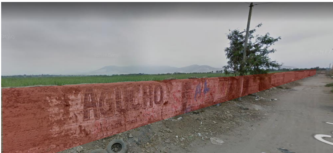
Fig. 32: Vista del terreno 2 desde la calle Carlos Manuel Cox
