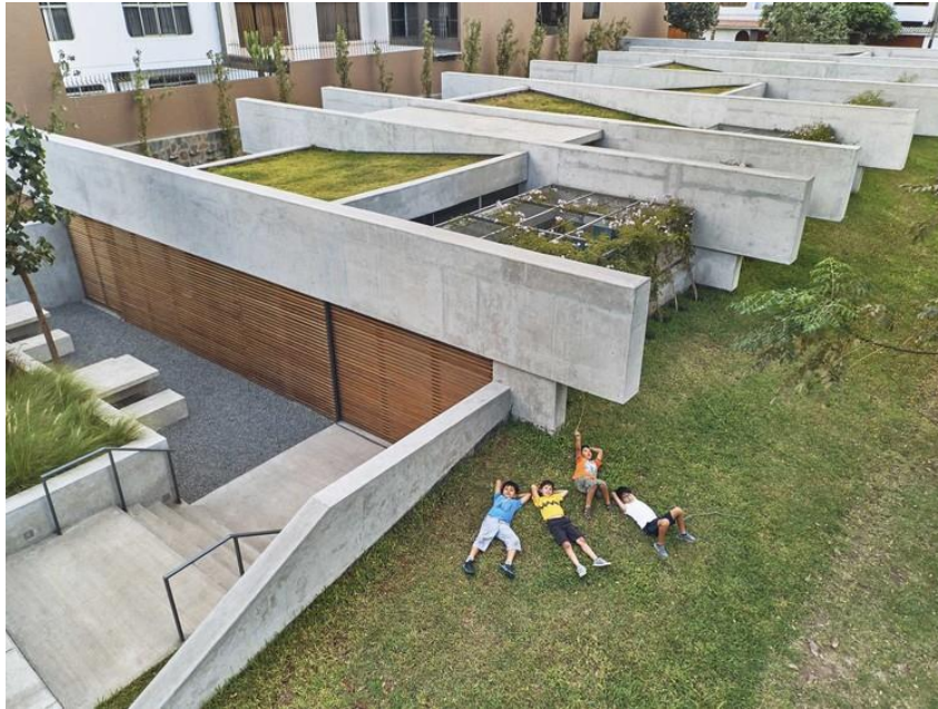
Figura 11. Vista general del caso N°3 Fuente: Archdaily.pe
