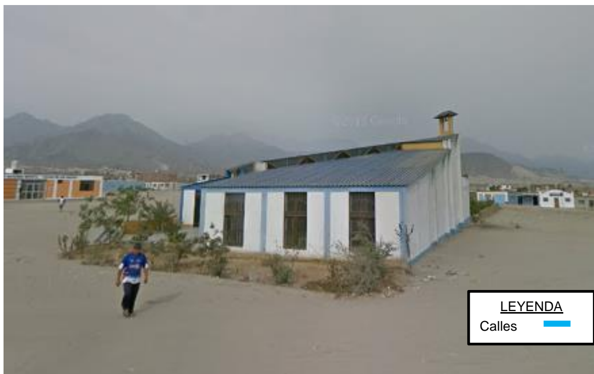
Figura 37. Vista este del terreno N°2
