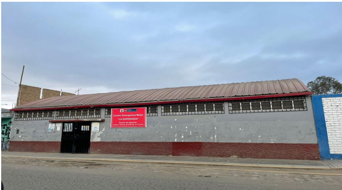
Figura 29. Fachada de ingreso al CEM
