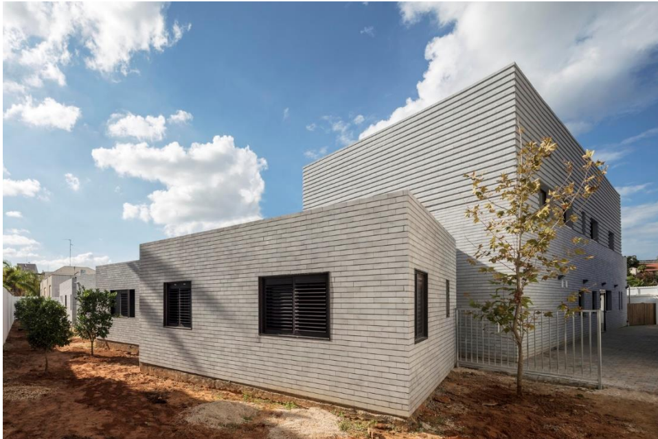
Figura 2: Vista general del caso 02
