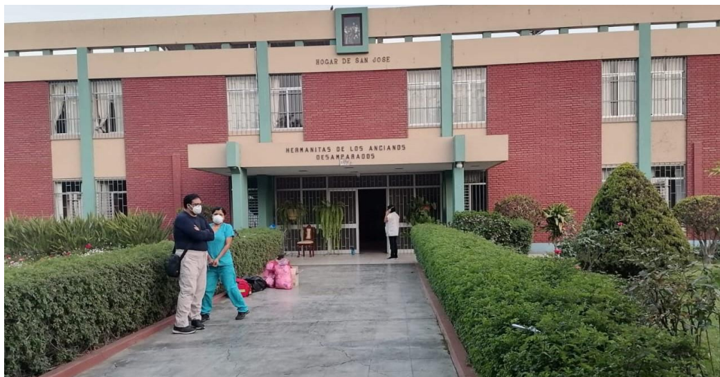
Figura 3: Vista general del caso 03
