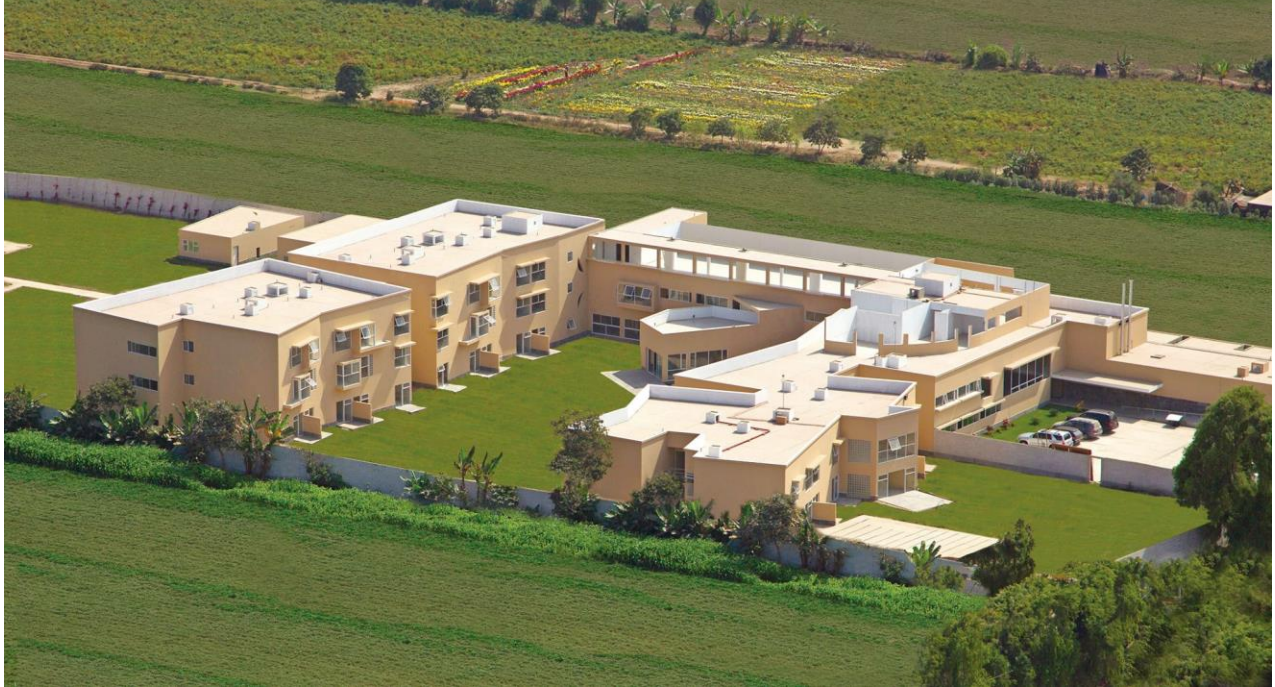
Figura 4: Vista general del caso 04
