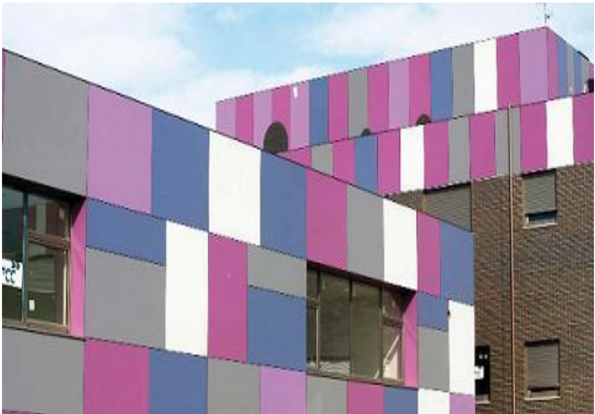
Figura 1: Vista general del caso 01
