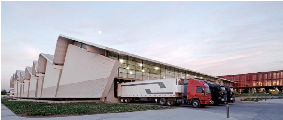
Ilustración 1: Vista principal de la Planta Procesadora de alimentos Carozzi
