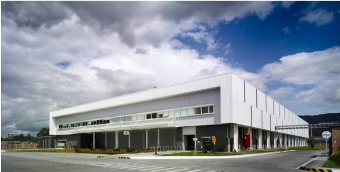
Ilustración 3: Vista principal de la Planta embotelladora Bravaria Brewery Tocancipá
