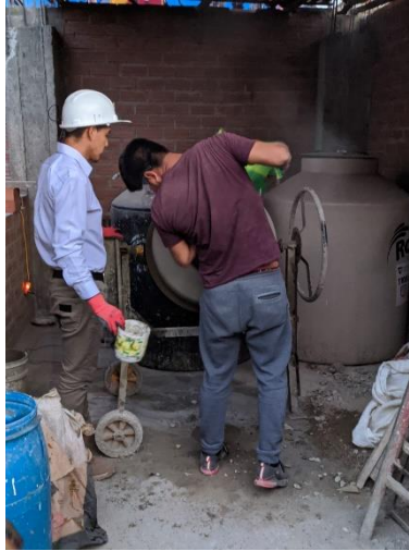
Ilustración 46. Etapa de mezclado de concreto
