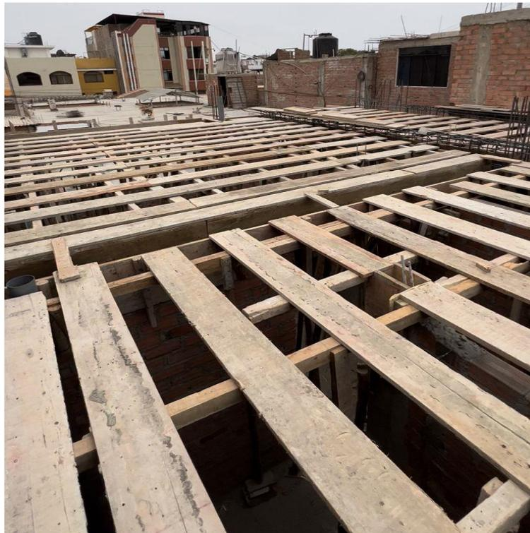
Una vez nivelado el encofrado, se procederá con la colocación de los ladrillos de techo, las dimensiones del ladrillo dependerán del espesor de la losa. Los ladrillos deberán estar alineados uno detrás de otro, sin dejar espacios, para así evitar filtraciones de concreto.
