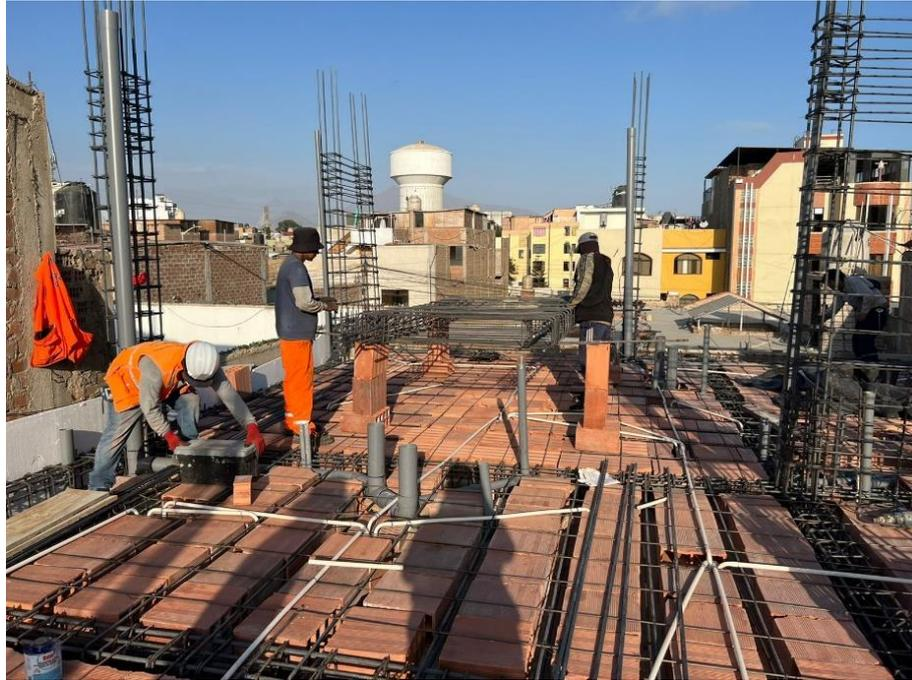
Previo al vaciado, se deberá colocar las varillas para el refuerzo de temperatura, estas se colocan en dirección perpendicular a la vigueta y se dan cada 25 cm. Este refuerzo se utiliza para resistir la contracción y las tensiones térmicas presentes en la losa.
