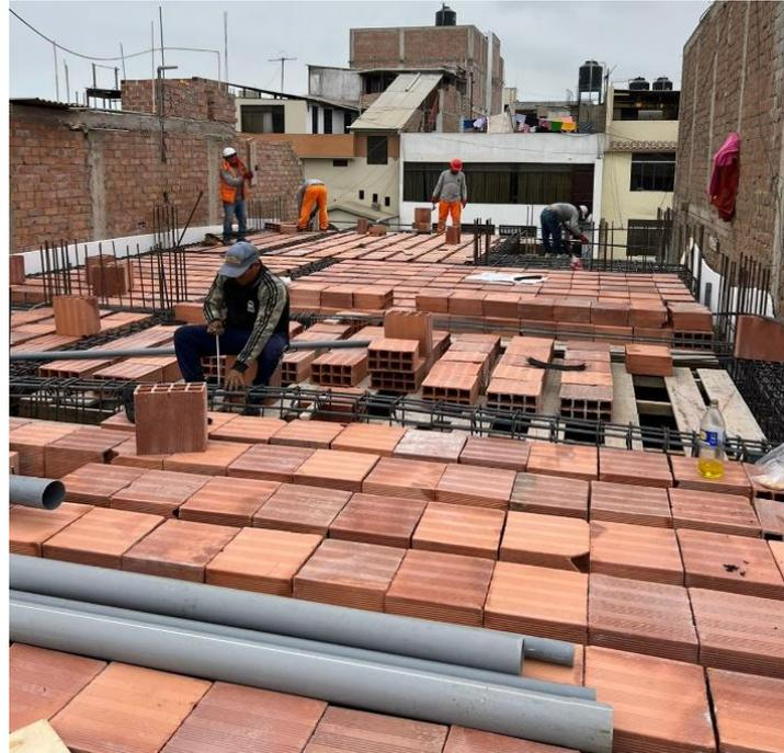
Una vez que se termine el tendido del ladrillo, se colocará el refuerzo positivo y negativo de las viguetas. Se debe asegurar que el acero positivo no esté en contacto con el encofrado, teniendo un recubrimiento como mínimo de 2 cm, que se logra amarrando la varilla con alambre N°16 al acero de temperatura. Los traslapes de los refuerzos no se deben dar en el centro de la losa, preferiblemente en los extremos.
