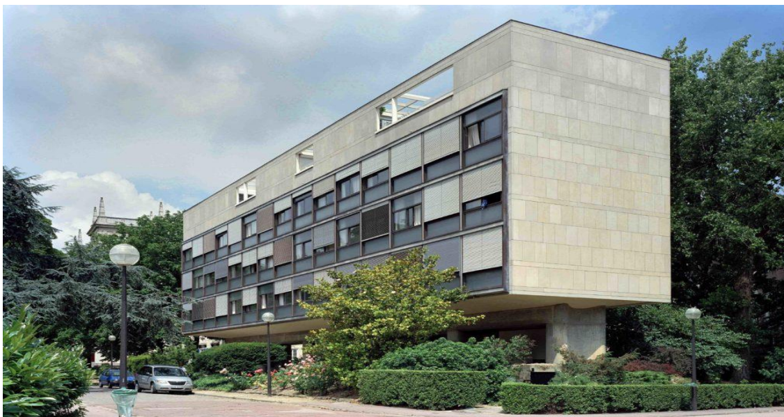
Figura 2: Vista general del caso 02
