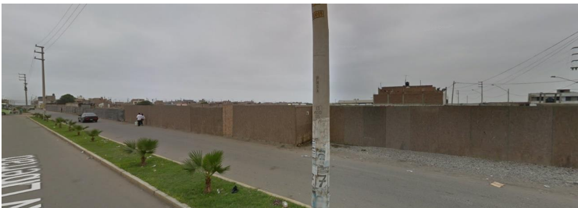
Figura 36: Vista del terreno N° 3 desde la Av. Libertad Fuente: Google Maps
