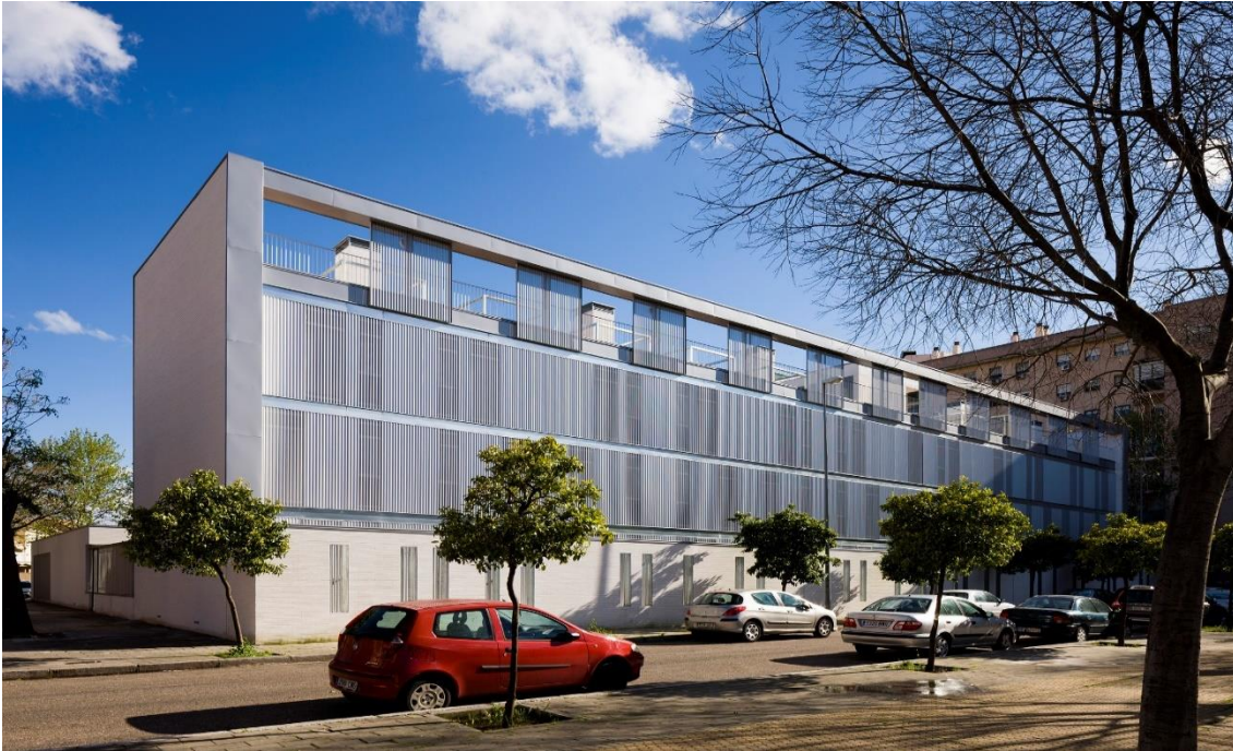
Figura 1: Vista general del caso 01
