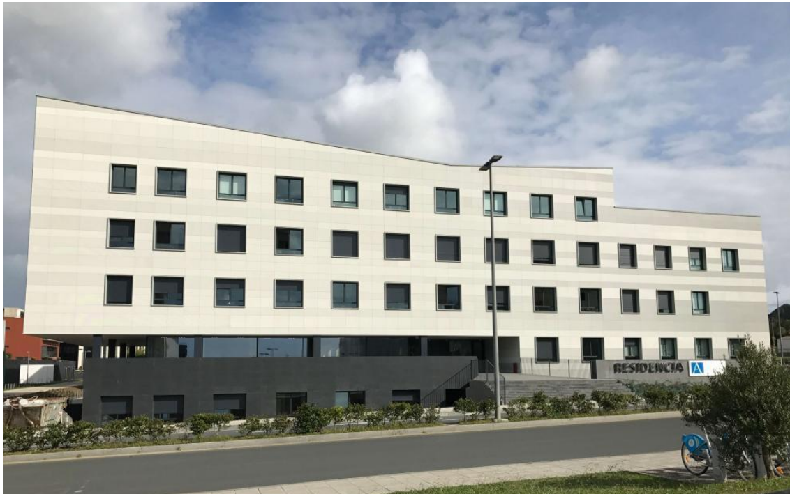
Figura 3: Vista general del caso 03
