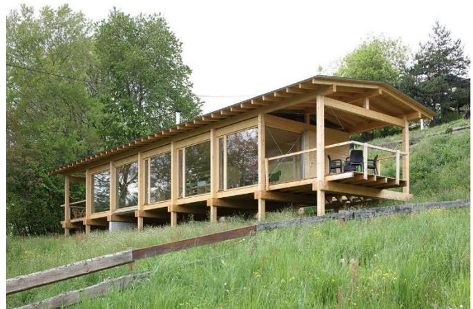
Con el objetivo de respetar la y causar el menor impacto sobre el suelo, se pretende "separar" a la arquitectura del nivel natural de terreno con el uso de pilotes
