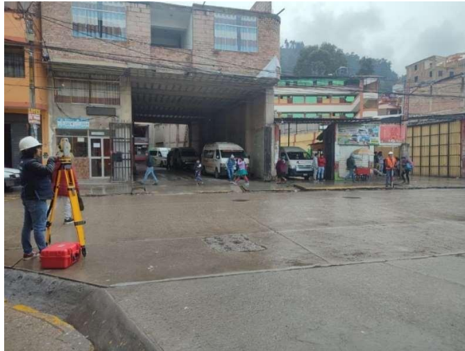
Fotografía N°01: Toma de puntos de la sección de la vía en la zona de estudio número 2.
