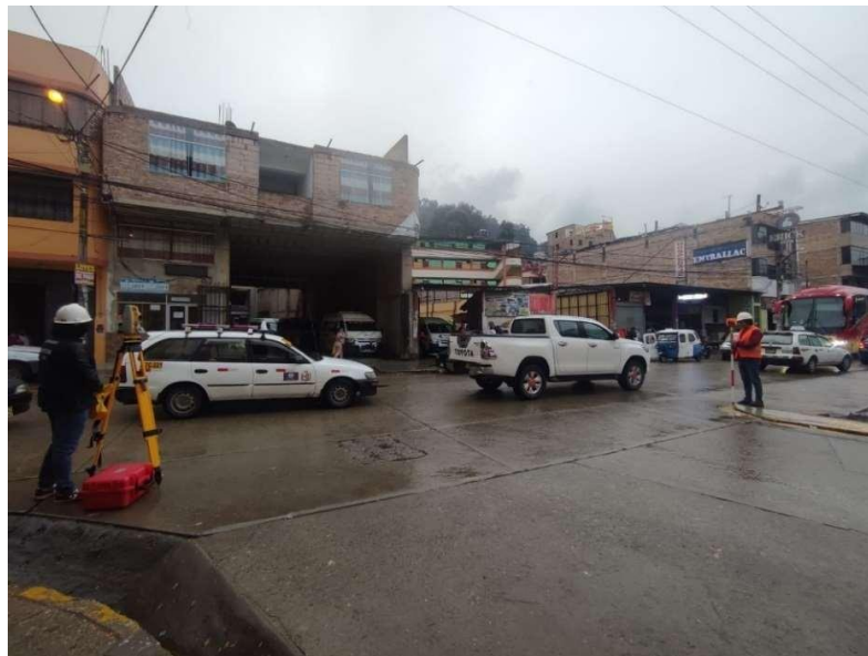
Fotografía N°02: Toma de puntos de la sección de la vía en la zona de estudio número 2
