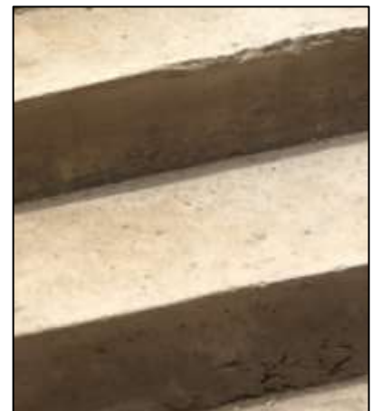
Fotografía N° 14. Desencofrado erróneo.
