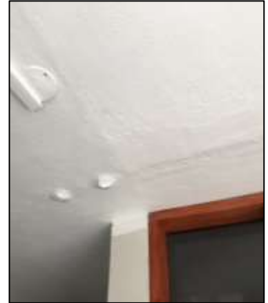
Fotografía N° 17. Tarrajeo en cielorraso.
