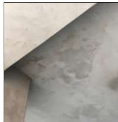
Fotografía N° 35. Infiltración cielorraso.
