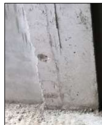
Fotografía N° 38. Desencofrado de columna.
