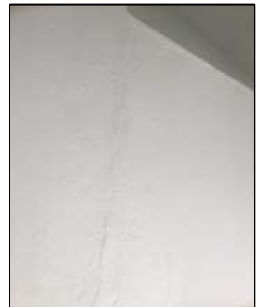
Fotografía N° 20. Pintura en muros
