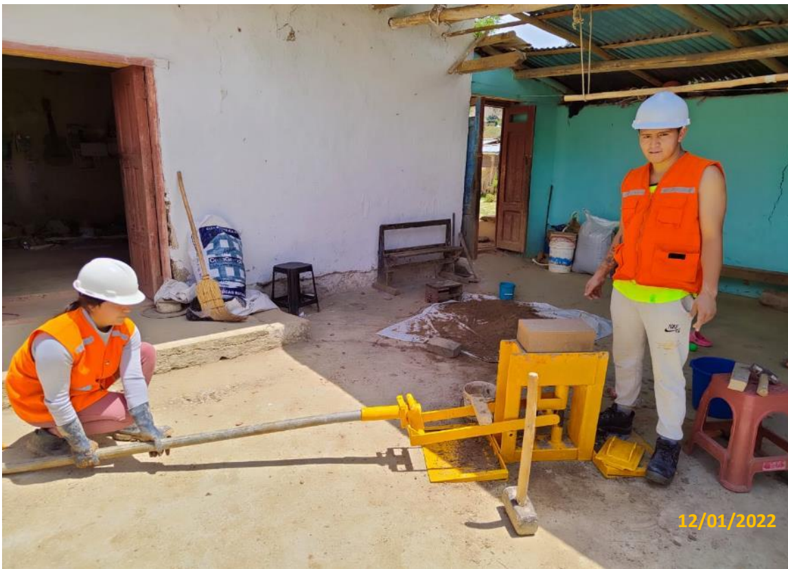
Nota: Adobe compactado realizado.
