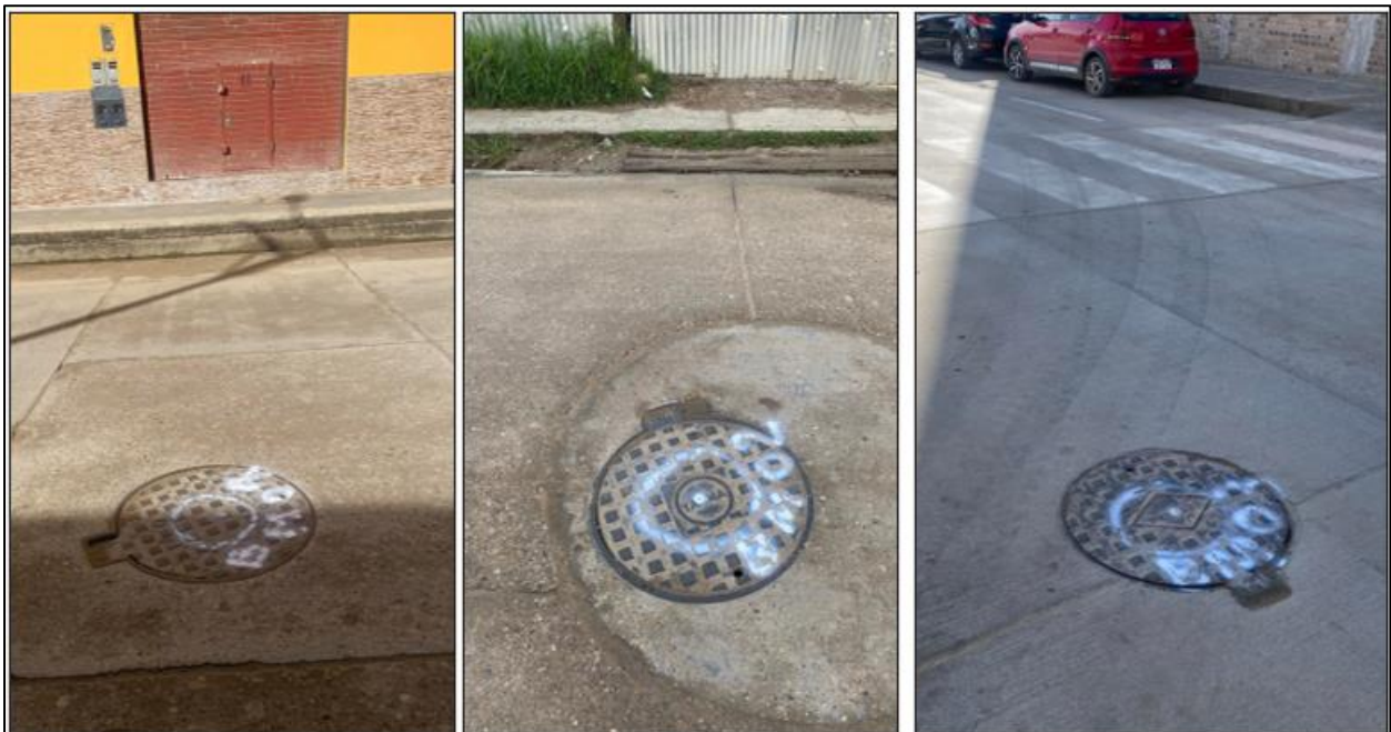
Figura 53. Materialización de los 3 Bm's, puntos de referencia del Levantamiento Topográfico de la zona.
