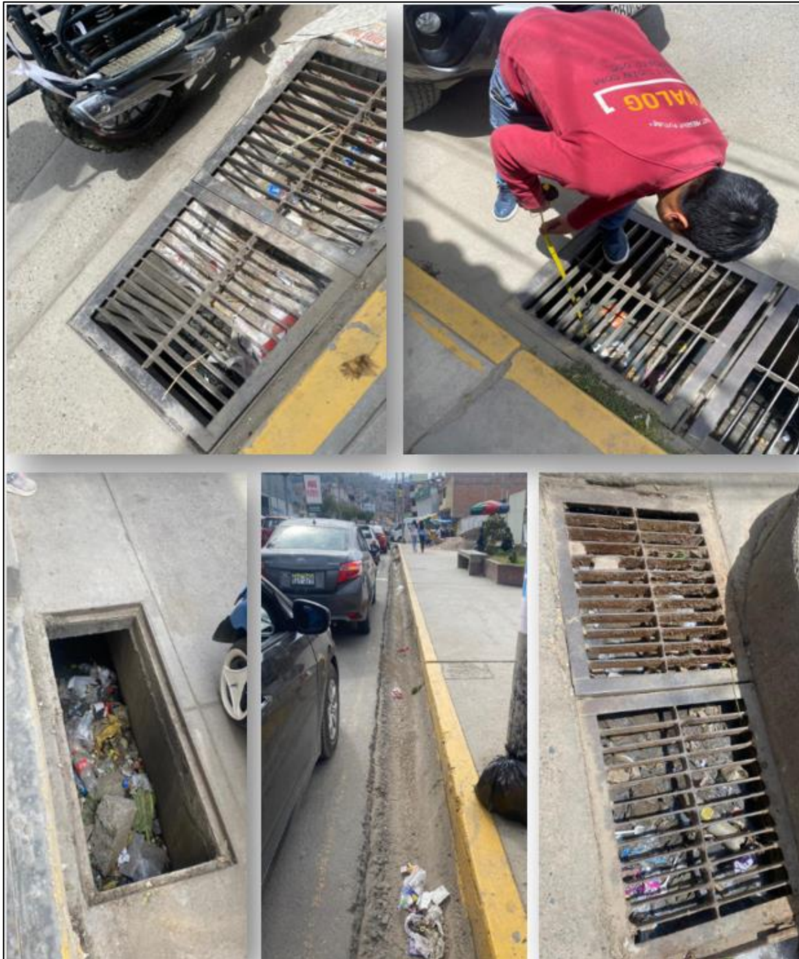
Figura 47. Existencia de desechos (basura) en los diferentes canales de drenaje pluvial de la zona.
