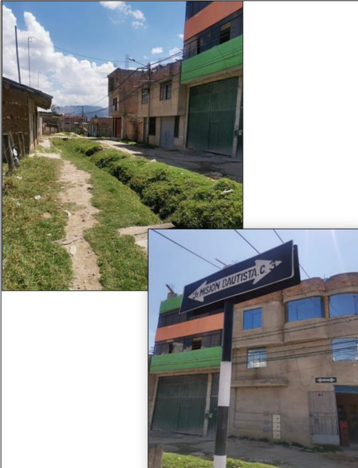
Figura 49. Calle sin pavimentar en mal estado - Jr. Misión Bautista C-3.
