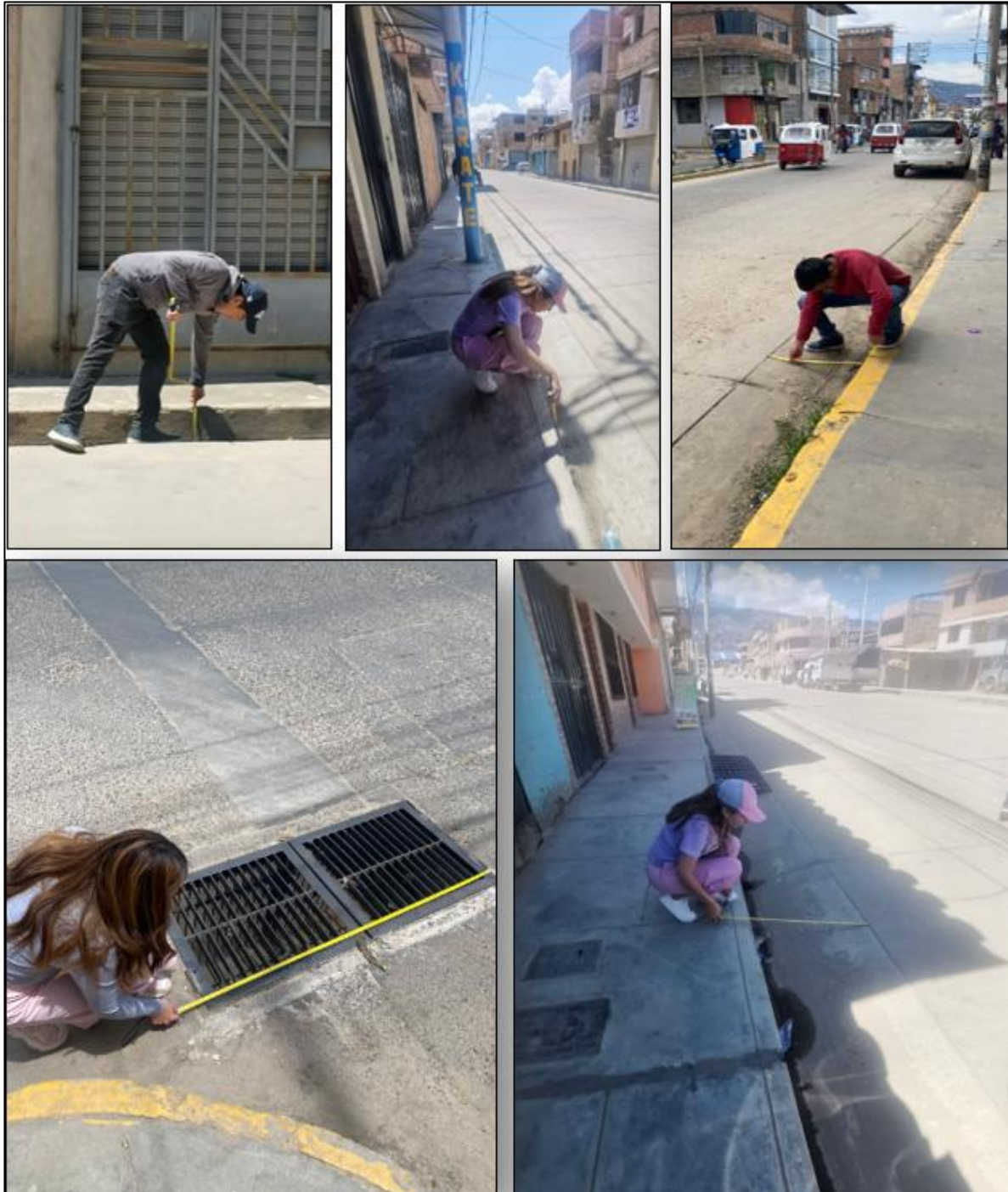
Figura 50. Medición de alto y ancho de las diferentes cunetas existentes en el Barrio San Martín de Porres.
