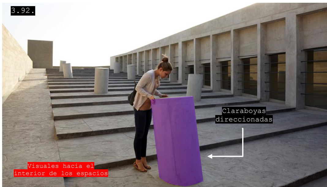
Figura 3.92. Claraboyas de concreto, Lugar de la memoria. (redfundamentos, 2014)
